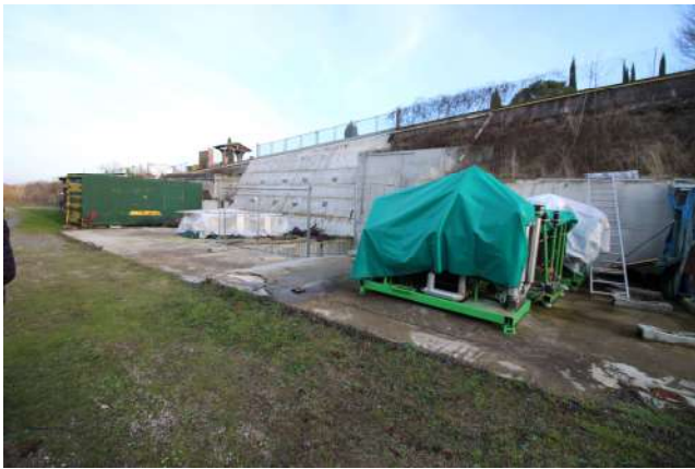
Foto 135: vista sull'area e macchinari ancora non rimossi
