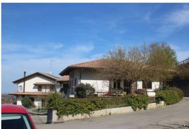
Foto 2: il complesso visto dal lato opposto all'ingresso
