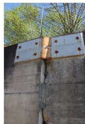
Foto 14-15-16: muro di sostegno sud e dettagli assestamenti e consolidamenti
