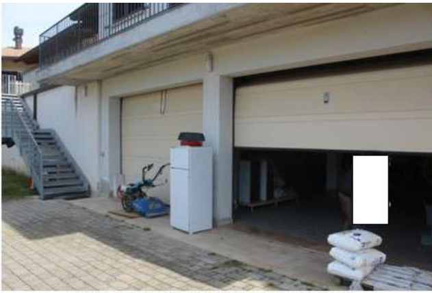
Foto 78: ingresso al deposito garage
