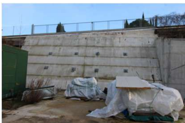
Foto 133-134: opere di sostegno e solette pavimentali in cemento armato ancora presenti sul posto.
