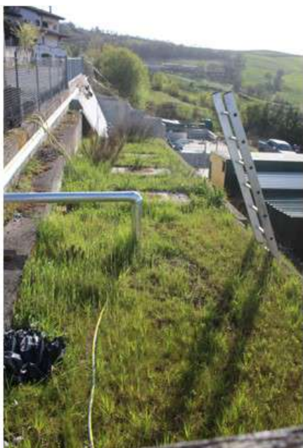
Foto 123: serbatoi idrico – vista da sopra
