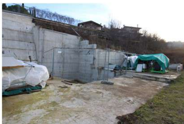
Foto 133-134: opere di sostegno e solette pavimentali in cemento armato ancora presenti sul posto.
