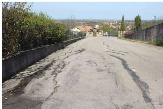
Foto 12-13: lesioni sulla carreggiata subparallele alle linee di equivello del versante
