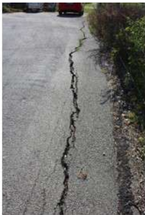
Foto 12-13: lesioni sulla carreggiata subparallele alle linee di equivello del versante
