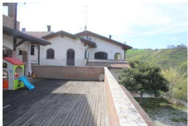
Foto 3: vista sui fabbricati in sequenza
