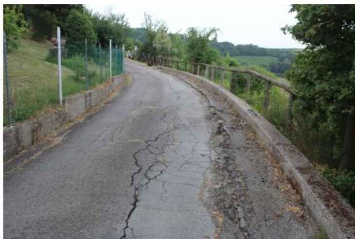
Foto 124: tratto della strada vicinale Palazzina posto al di sopra del complesso lato sud
