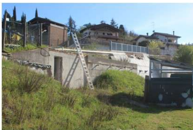
Foto 121: vista sul manufatto tecnico
