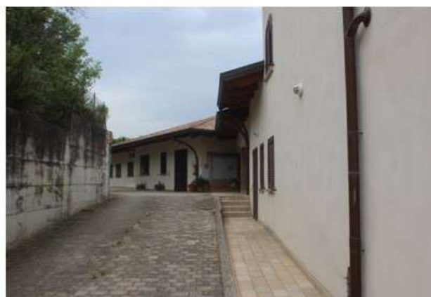
Foto 77: complesso – prospetto sud
