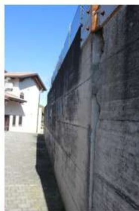
Foto 14-15-16: muro di sostegno sud e dettagli assestamenti e consolidamenti
