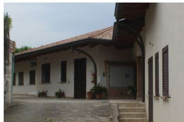
Foto 91: esterno – ingresso all'appartamento
