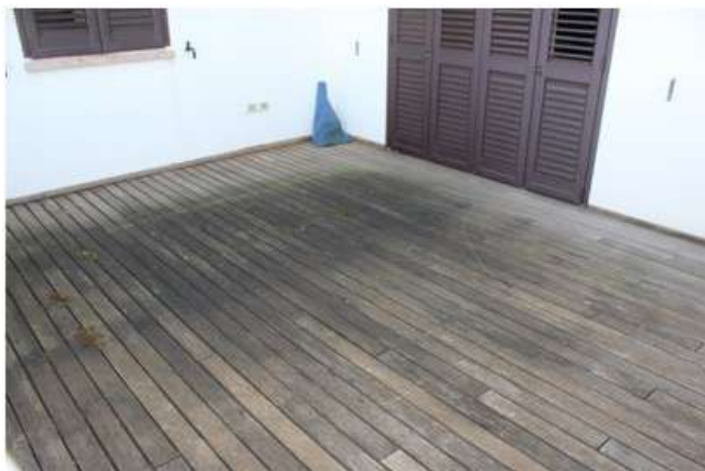
Foto 73 – 74: loggia e terrazzo
