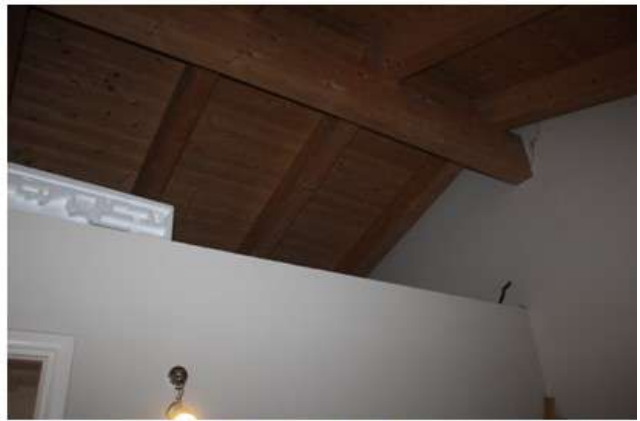
Foto 66: soppalco su guardaroba e copertura
