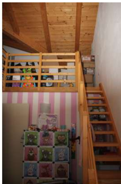
Foto 101: soppalco abusivo da camera da letto singola
