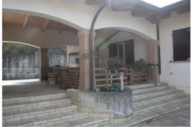
Foto 29: portico laterale al piano terra
