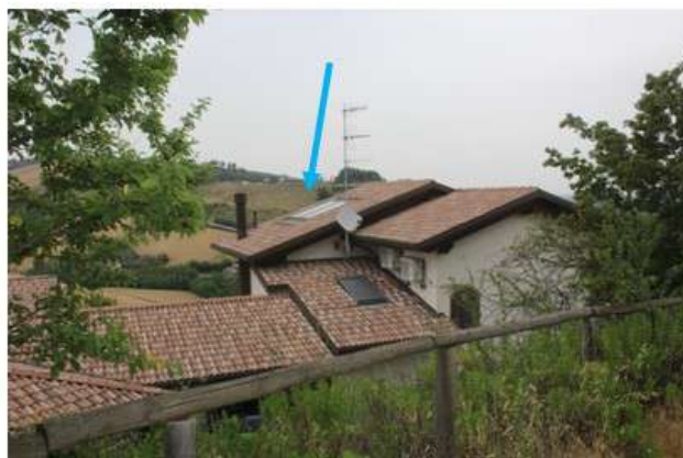
Foto 83: pannelli solari termici sopra abitazione lotto 1
