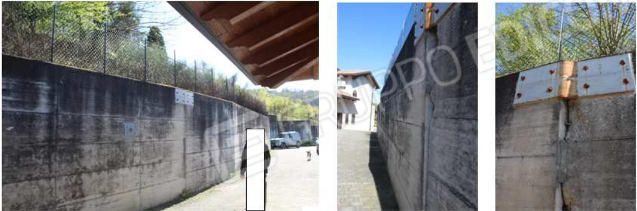
*Foto 14-15-16: muro di sostegno sud e dettagli assestamenti e consolidamenti*
