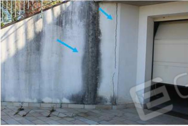
Foto 52: macchie e lesioni nel paramento a fianco del garage
