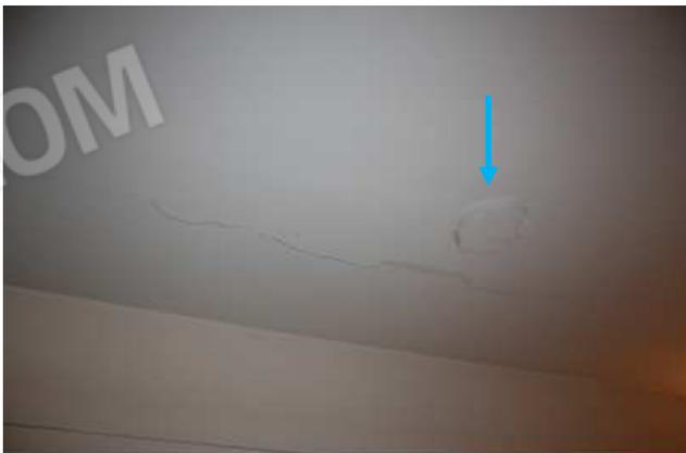
Foto 48: tracce di infiltrazioni sul soffitto del soggiorno
