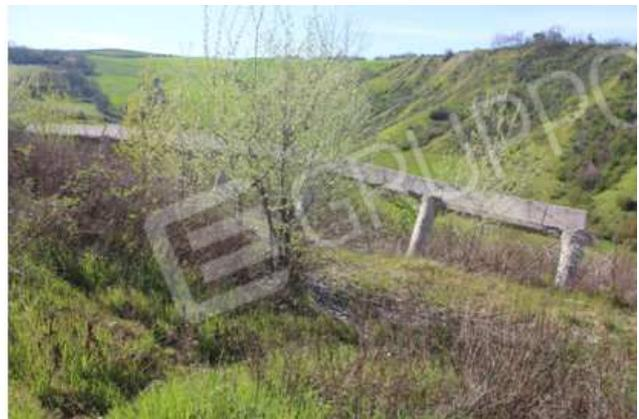
Foto 11: opere di contenimento dell'area di sosta franate
