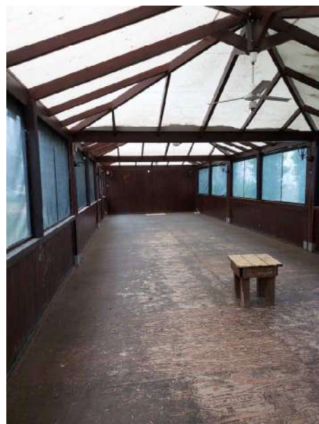
vista interna su sala pranzo
