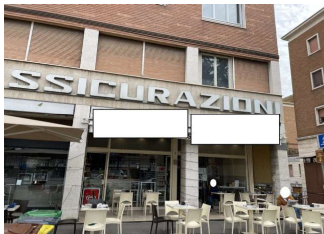
Vista esterna del fabbricato
