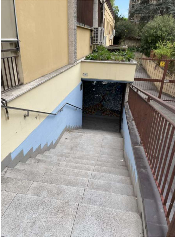
Passaggio comune esterno/seminterrato
