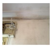
Sono necessari anche interventi di manutenzione e/o adeguamento degli impianti (tutti) specie l'impianto elettrico che non risulta a norma rispetto alle vigenti normative in materia ma solo all'epoca della sua realizzazione e per il fatto che in sede di sopralluogo sono state accertate prese aperte con fili a vista.
