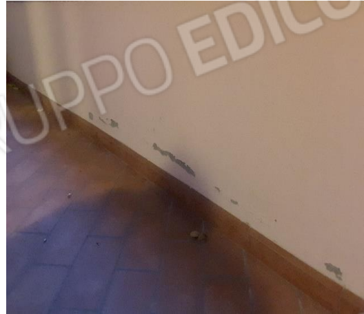
Vista dell'umidità nei parapetti dei balconi
