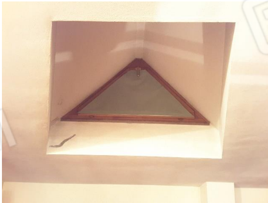
Vista delle infiltrazioni di acqua dai lucernai
