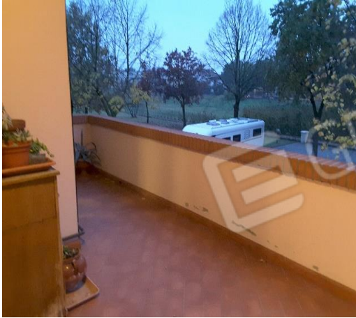
Vista dell'umidità nei parapetti dei balconi
