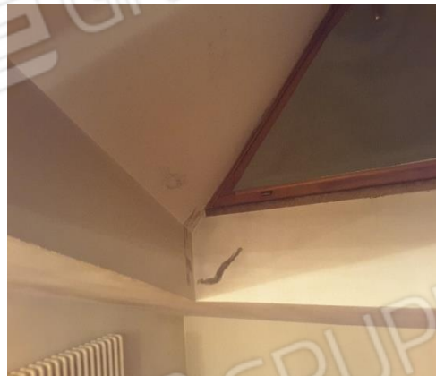
Vista delle infiltrazioni di acqua dai lucernai
