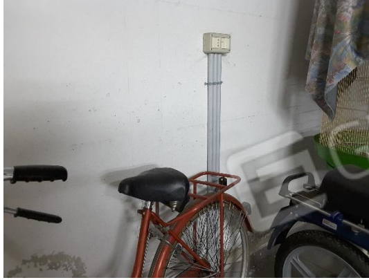
Vista dell'impianto elettrico in canaline esterne al piano interrato
