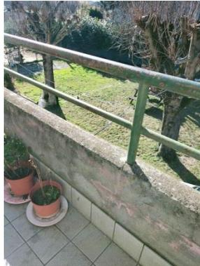
In occasione del sopralluogo è stato accertato che in corrispondenza del muro dell'abitazione erano mancanti degli spezzoni di pavimentazione ed inoltre il parapetto, in virtù delle attuali normative di sicurezza era basso (non a norma)
