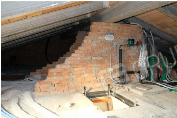
foto n.70 – veduta del sottotetto
