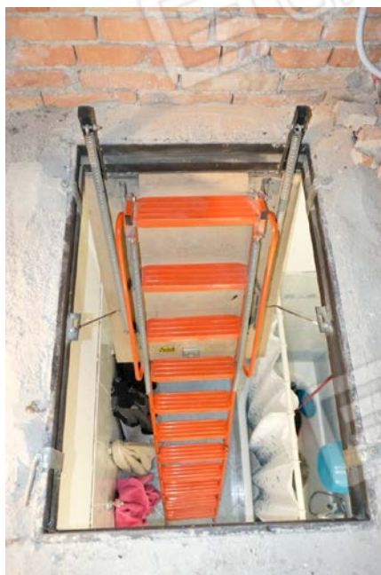
foto n.66-67 – veduta e particolare della botola di accesso al sottotetto
