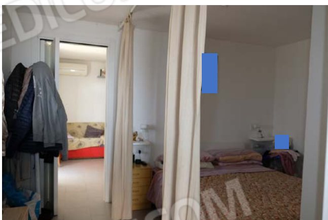
foto n.85 – veduta dell'accesso all'autorimessa dal cortile esterno e dell'interno dell'autorimessa utilizzata, impropriamente, come appartamento
