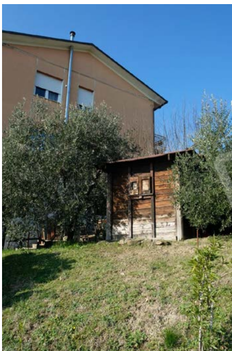
foto n.5 - veduta di parte dell'intero fabbricato in cui sono ubicate le u.i. oggetto di procedura (retro)
