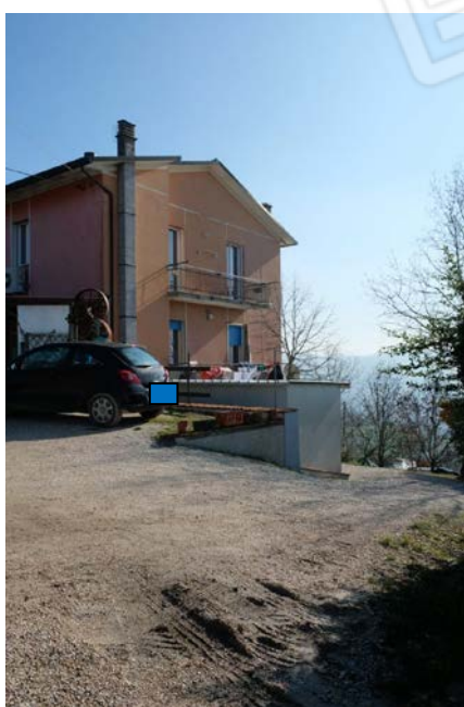
foto n.16-17 - veduta del retro del ripostiglio identificato con il sub.9 (bene comune non censibile), di parte della corte comune alle unità oggetto di procedura, anch'essa identificata con il sub.9 e di parte della corte comune a tutte le unità insistenti sulla particella 138, identificata con il sub.10.
