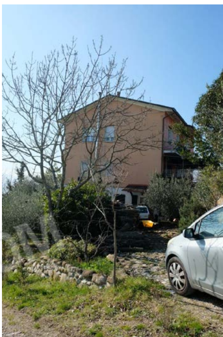
foto n.3 - veduta di parte dell'intero fabbricato in cui sono ubicate le u.i. oggetto di procedura, dallo stradello di accesso alla particella 138
