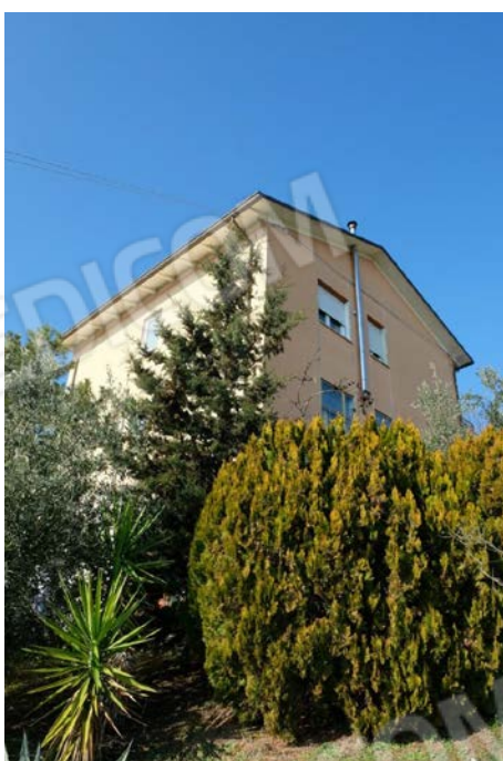
foto n.4 - veduta di parte dell'intero fabbricato in cui sono ubicate le u.i. oggetto di procedura (lato stradello di accesso e parte del retro)
