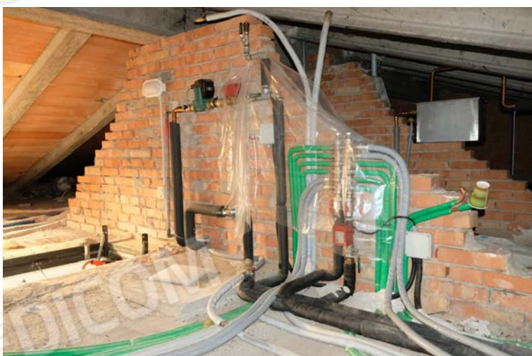
foto n.72 – veduta del sottotetto
