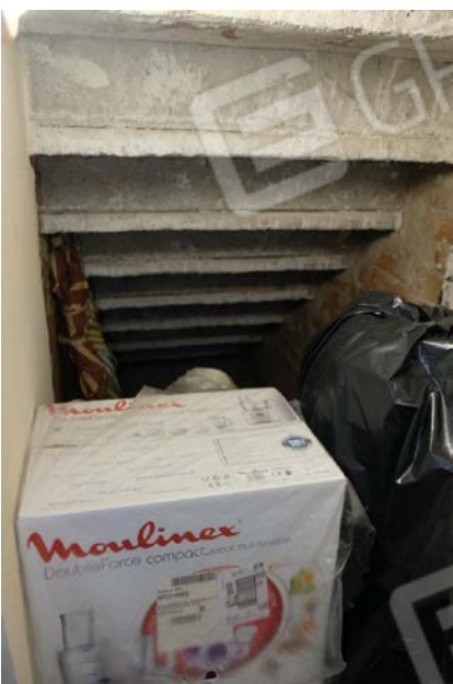
foto n.79-80 – veduta del sottoscala
