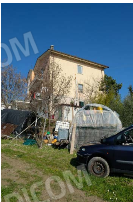
foto n.7 - veduta di parte dell'intero fabbricato in cui sono ubicate le u.i. oggetto di procedura (retro e fianco lato particella 139)
