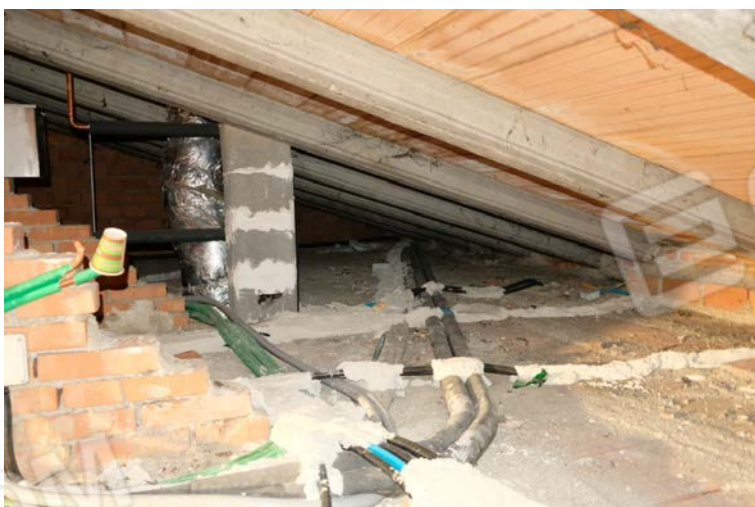
foto n.71 – veduta del sottotetto
