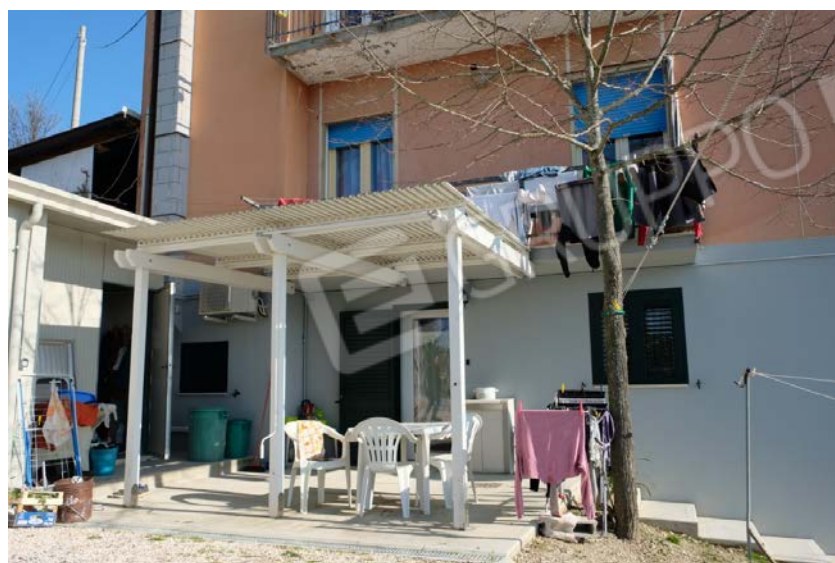
foto n.12 - veduta di parte del ripostiglio identificato con il sub.9 (bene comune non censibile), della tettoia realizzata senza titolo autorizzativo e della porta di accesso all'autorimessa, utilizzata impropriamente come appartamento.
