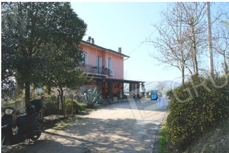
foto n.2 - veduta di parte dell'intero fabbricato in cui sono ubicate le u.i. oggetto di procedura e della corte comune identificata con il sub.10
