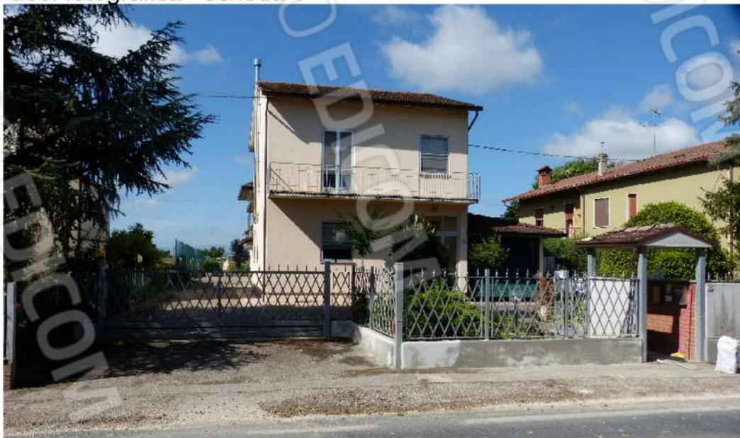
vista esterna accesso carrabile e pedonale
