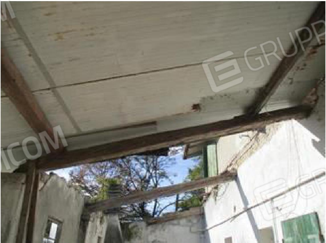
FOTO 7. Fabbricato ad uso abitazione: particolare del portico (copertura sostituita da pannelli sandwich)
