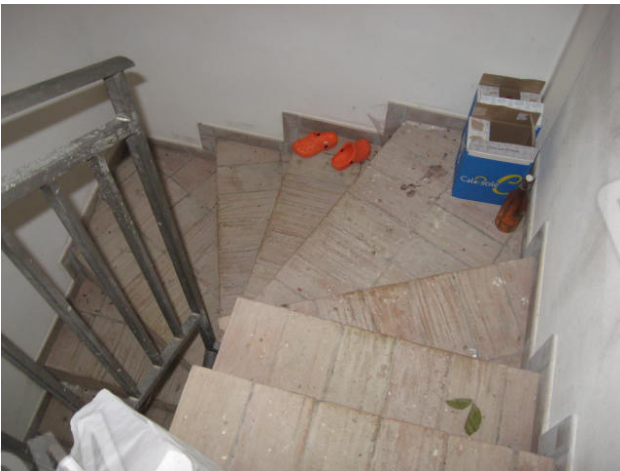
Scala accesso cantina e particolare cantina
