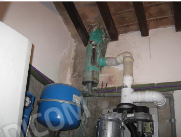
Zona centrale termica nel manufatto autonomo (ovest) e bagno
