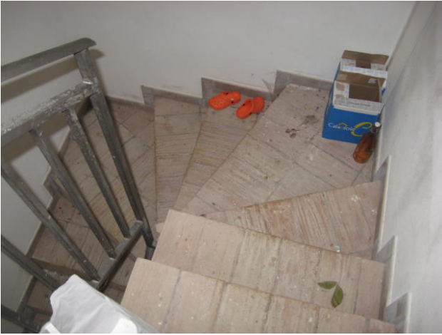
Scala accesso cantina e particolare cantina
