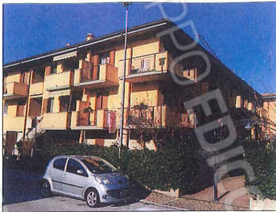
FOTO 1 - CONDOMINIO SAN ROCCO
