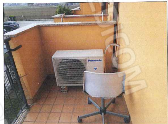
FOTO 40 - RAFFRESCAMENTO UNITA' ESTERNA
