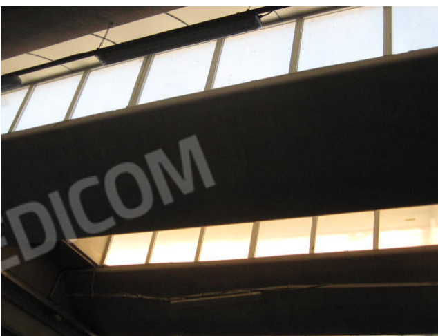
Shed/copertura corpo centrale
