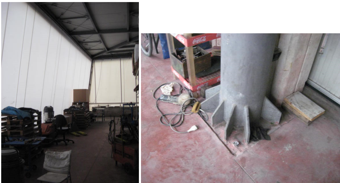
Pensilina fronte nord con telo in pvc e piede pilastro in metallo a sezione circolare della pensilina
