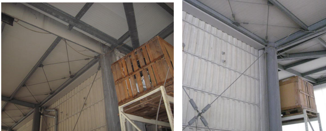
Particolare pensilina esterna
