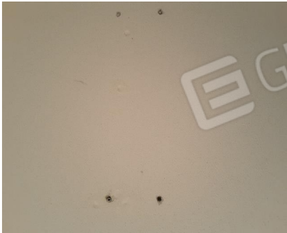
Vista presenza di alcuni fori nelle pareti sia del soggiorno sia delle camere da letto
