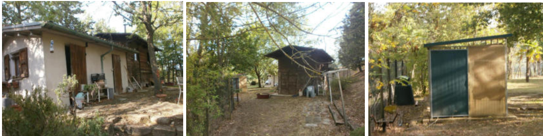
I fabbricati di servizio: capanno in muratura, capanno in legno, ricovero per cani
