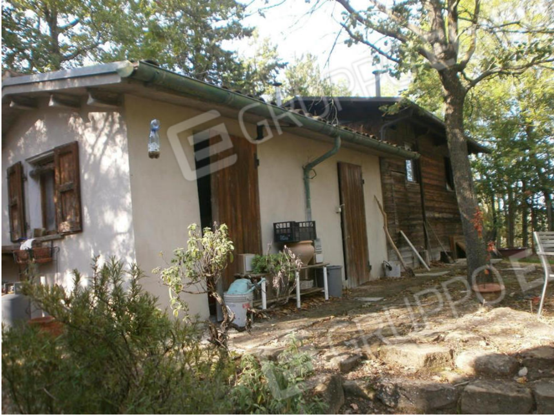
FOTO 29. Servizi: capanno in muratura e adiacente capanno in legno
