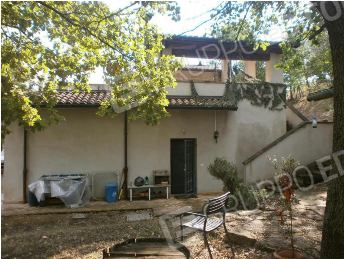
FOTO 7. Prospetto sul retro
