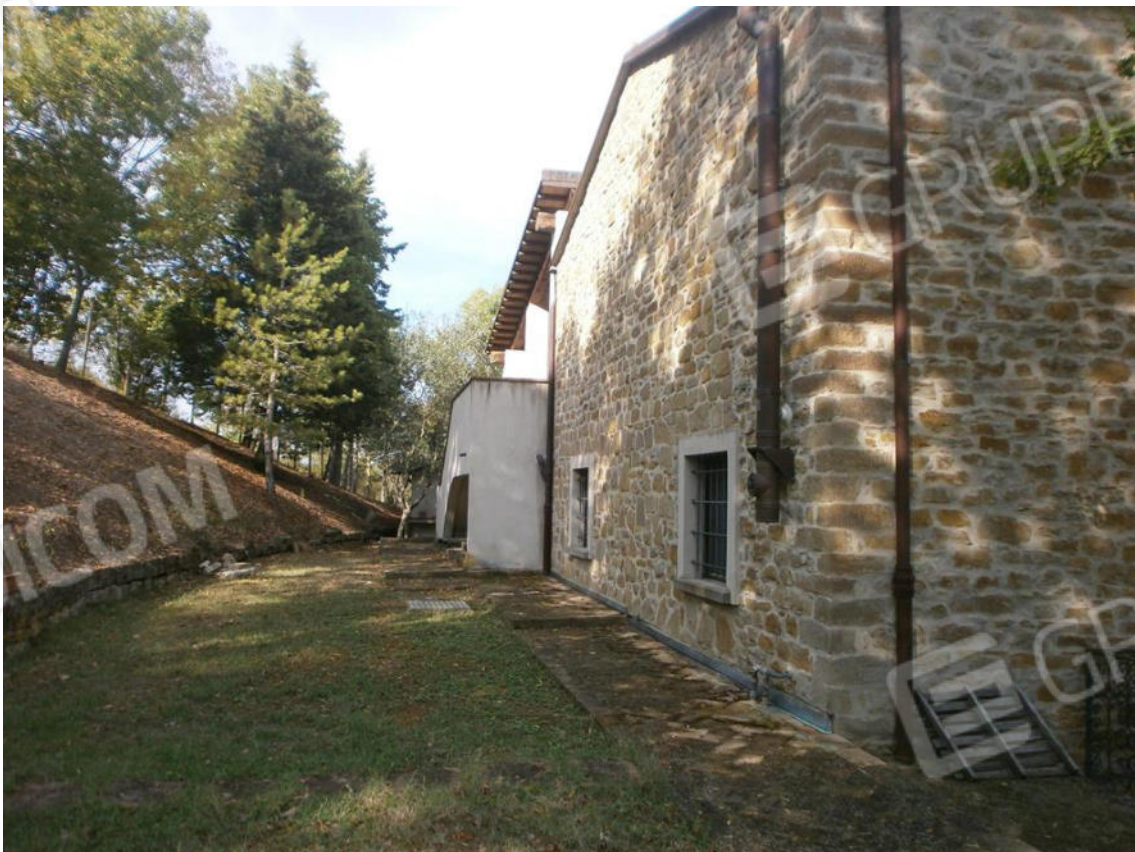
FOTO 6. Prospetto sul retro
