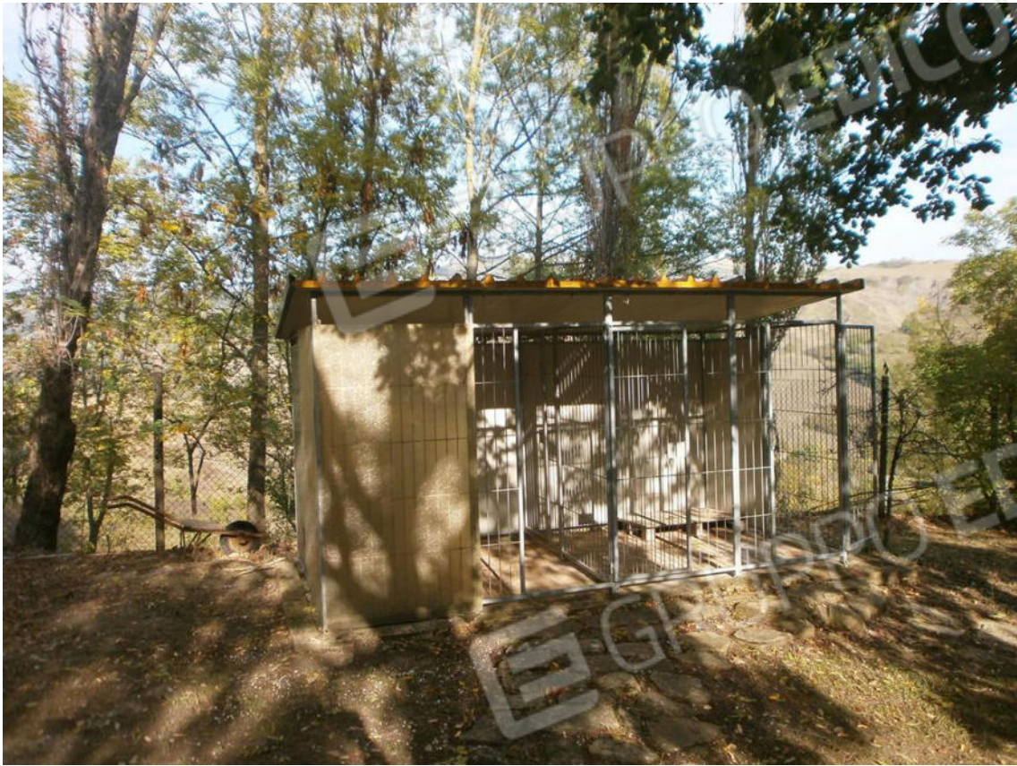
FOTO 31. Servizi: fabbricato ad uso canile
