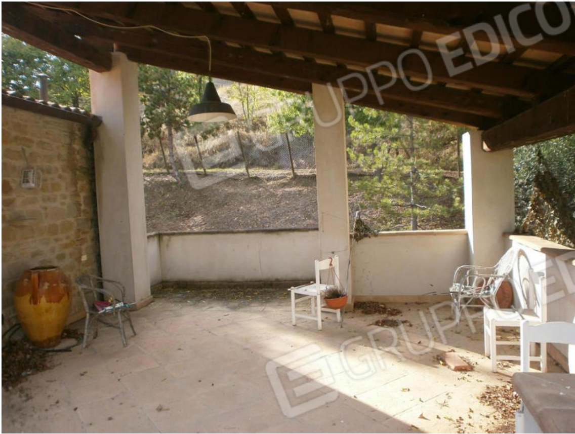
FOTO 27. Piano primo: loggia
