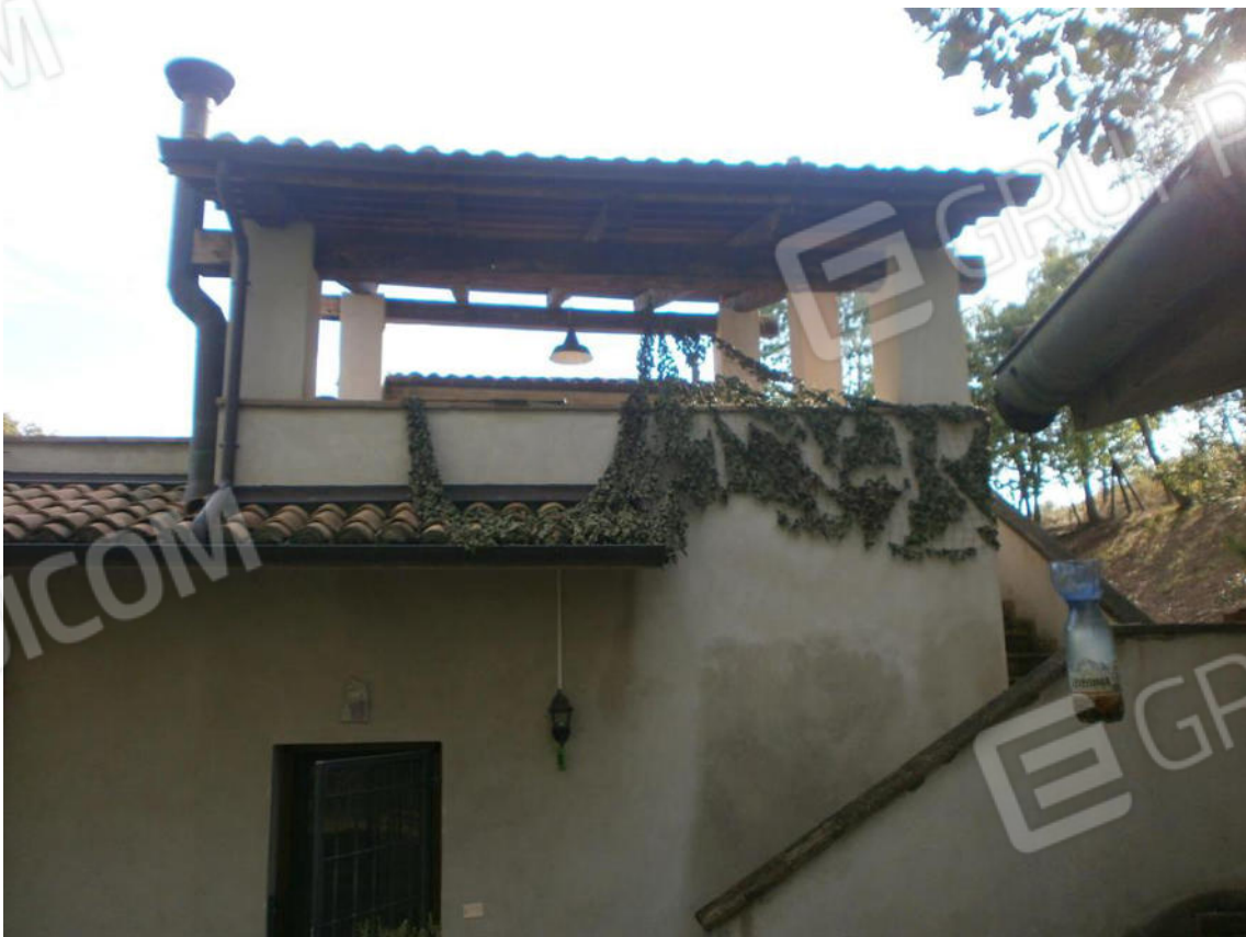
FOTO 8. Prospetto sul retro: particolare della loggia
