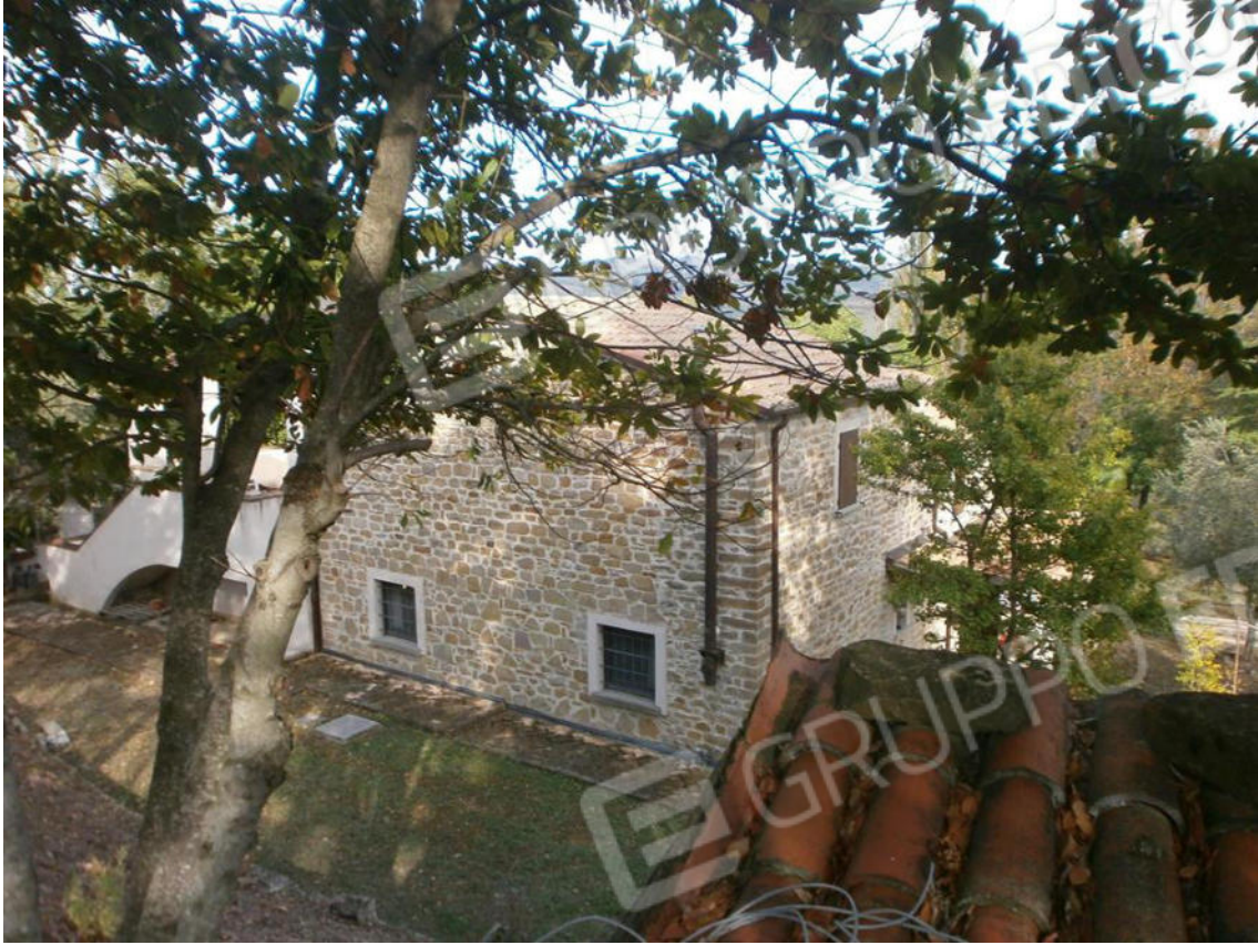
FOTO 5. Prospetto sul retro
