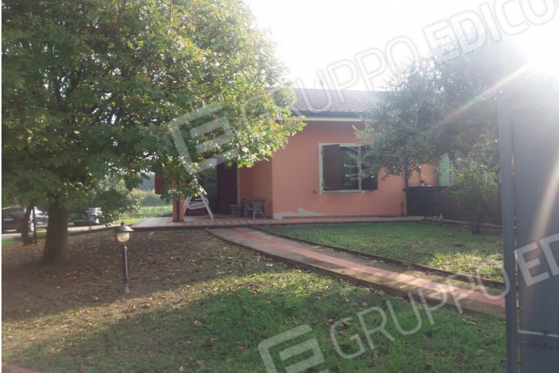
Vista esterna fronte fabbricato
