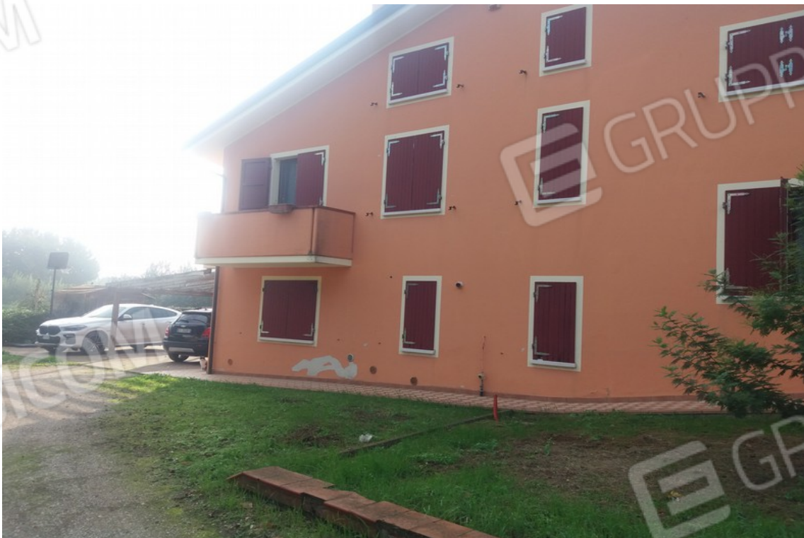
Vista esterna fianco del fabbricato
