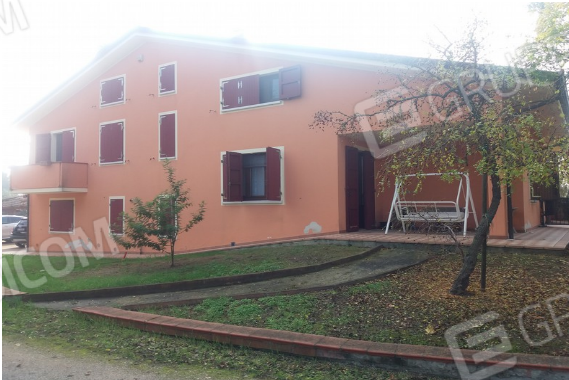
Vista esterna fianco del fabbricato
