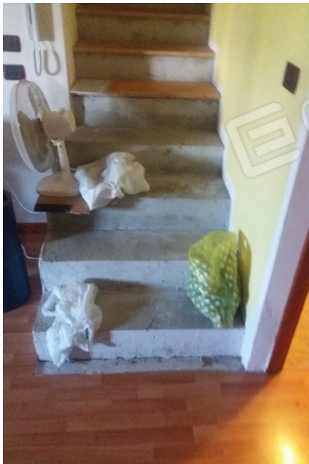
particolare scala di accesso al piano sottotetto
