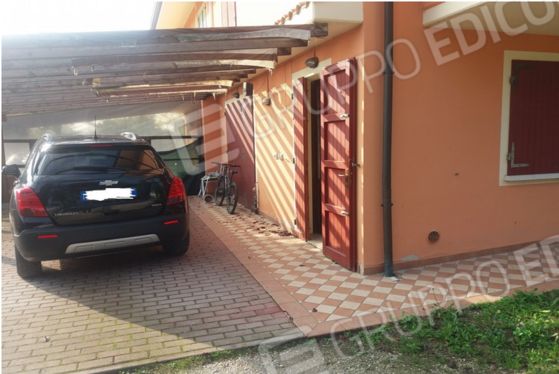
Vista esterna retro del fabbricato con particolare del pergolato
