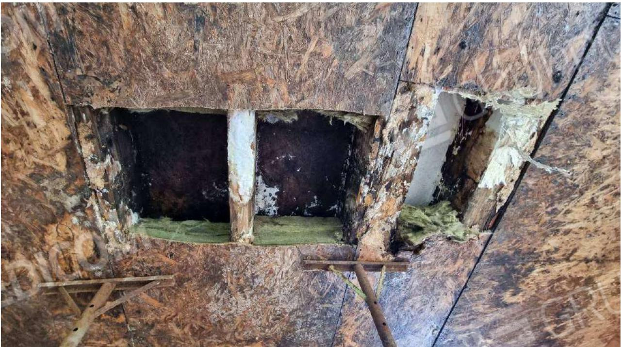
Piano terra : solaio deteriorato
