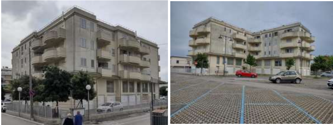
Il fabbricato condominiale polifunzionale che contiene i beni pignorati
