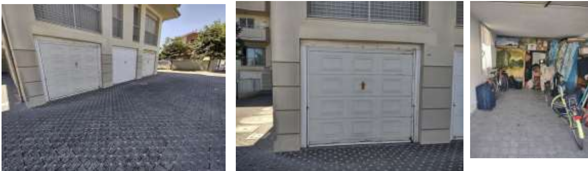
Garage sub 49: vista del portone basculante e dell'interno
