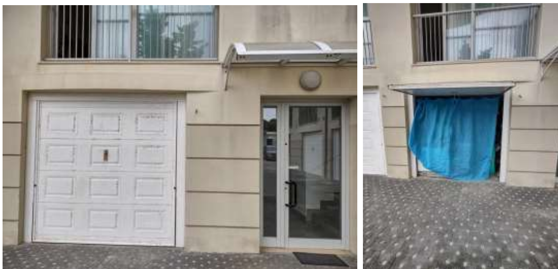
Garage sub 30: portone basculante e interno
