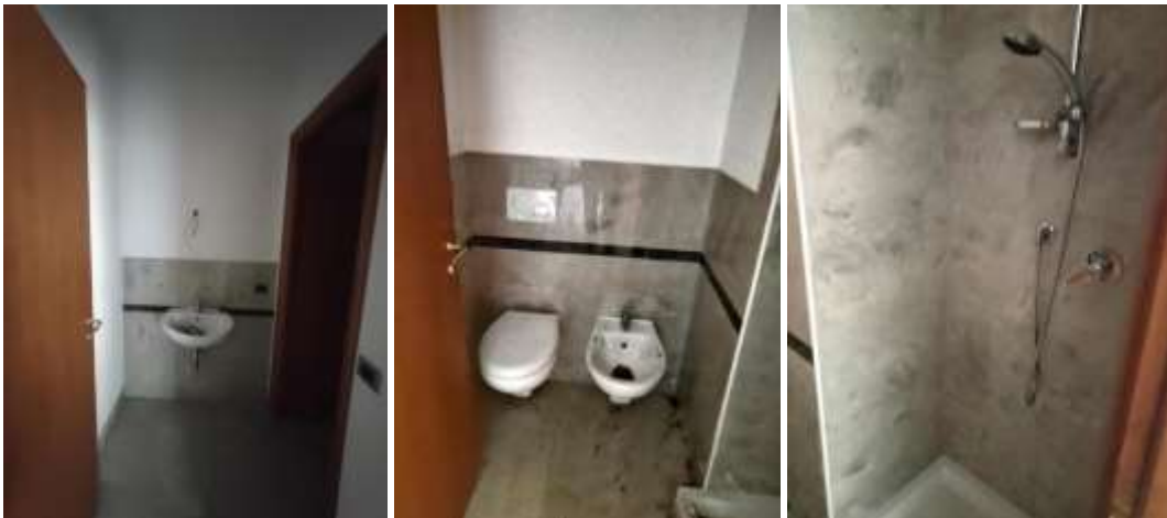
Ufficio: antibagno e bagno
