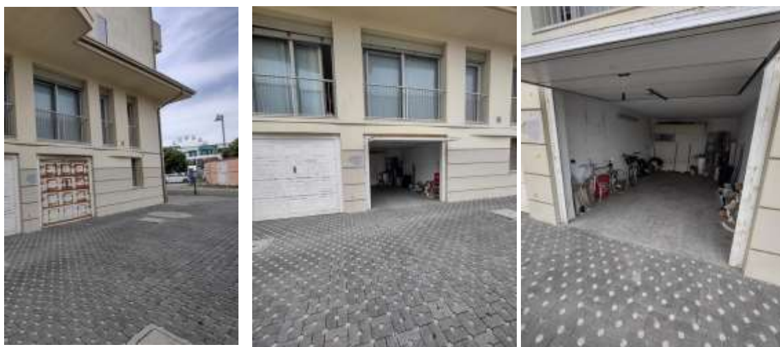
Garage: basculante e vista dell'interno
