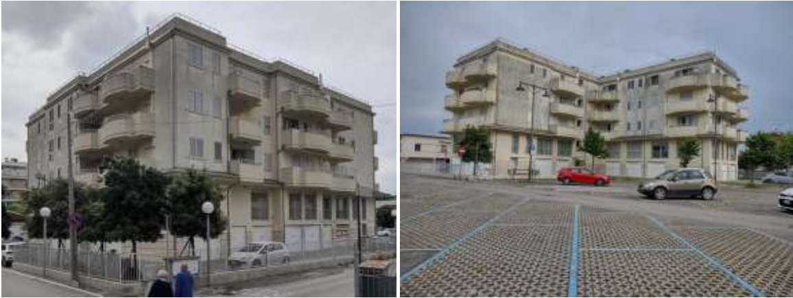
Il fabbricato condominiale polifunzionale che contiene i beni pignorati
