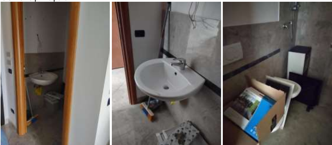
Ufficio: antibagno e bagno
