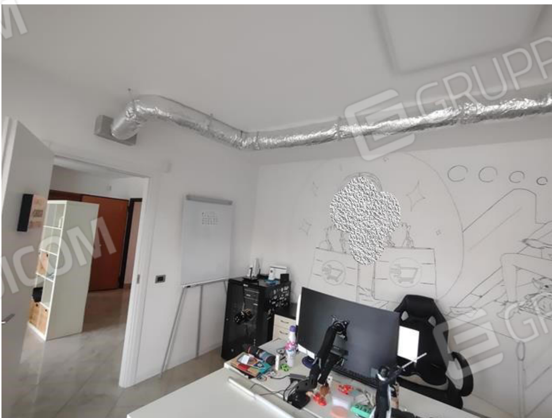
FOTO 10. Ufficio (sub 4): il terzo vano
