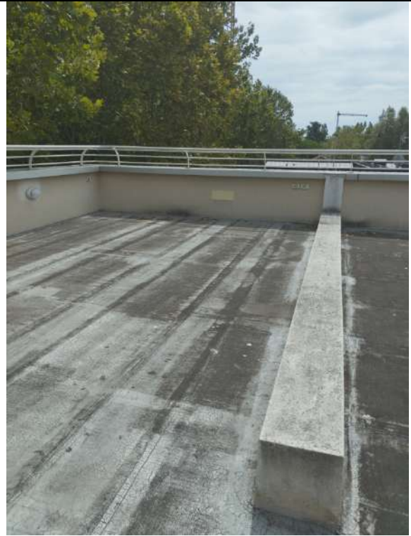
Lastrico solare Sub.15
