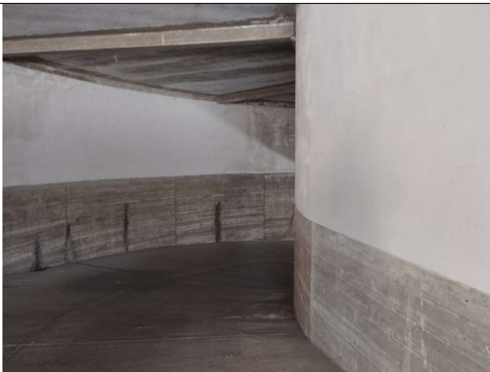
Particolare della rampa
