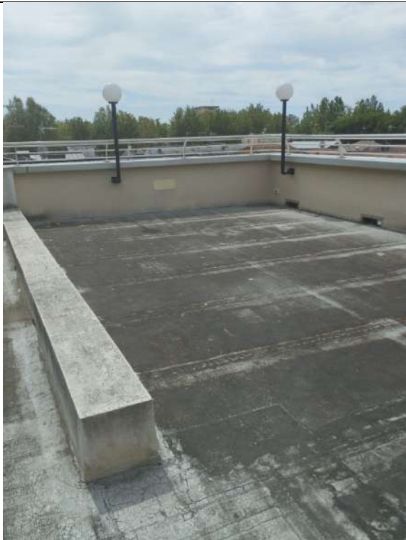
Lastrico solare Sub.14
