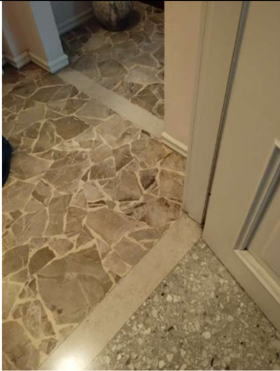
Particolare della pavimentazione
