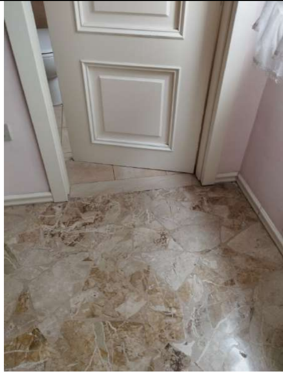
Particolare della "camera da letto"
