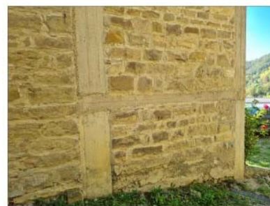
FOTO 45 - MURATURA IN PIETRA
