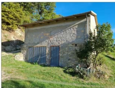
FOTO 14 - FABBRICATO STACCATO DEPOSITO CANTINA
