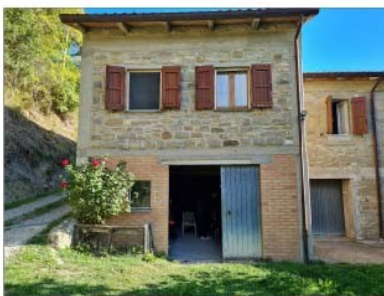
FOTO 05 - VISTA DEL PIANO SEMINTERRATO A SERVIZI
