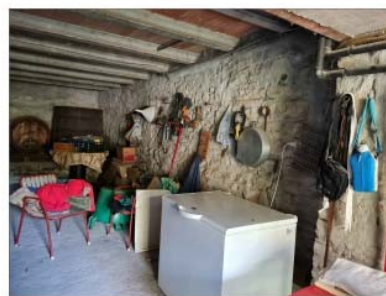
FOTO 30 - PIANO SEMINTERRATO CANTINA
