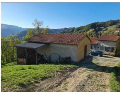
FOTO 35 - VISTA DELLA PROPRIETÀ
