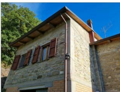
FOTO 08 - VISTA DELLA COPERTURA E DEL CAMINO
