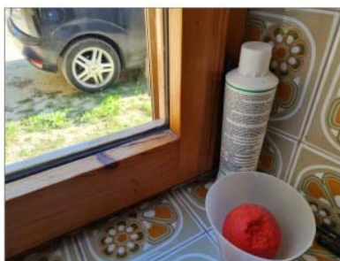
FOTO 41 - INFISSI IN LEGNO
