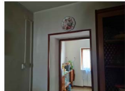
FOTO 27 - MURATURE PORTANTI INTERNE
