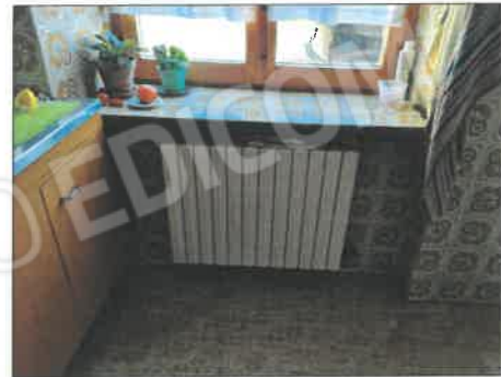
FOTO 39 - RADIATORE RISCALDAMENTO
