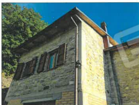
FOTO 08 - VISTA DELLA COPERTURA E DEL CAMINO
