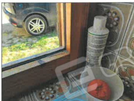
FOTO 41 - INFISSI IN LEGNO
