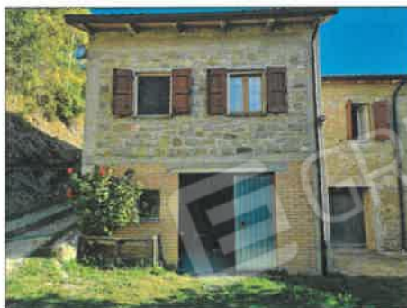
FOTO 05 - VISTA DEL PIANO SEMINTERRATO A SERVIZI
