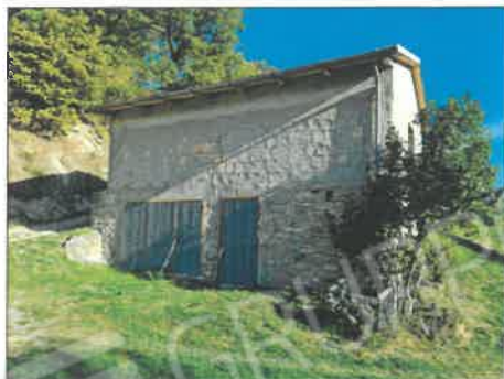
FOTO 14 - FABBRICATO STACCATO DEPOSITO CANTINA
