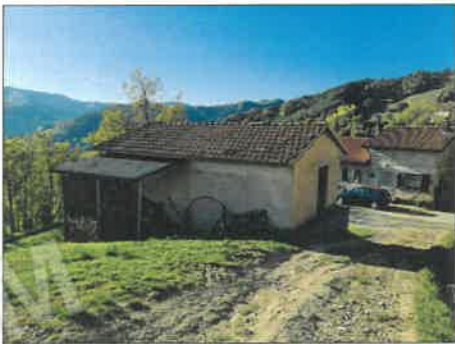
FOTO 35 - VISTA DELLA PROPRIETÀ
