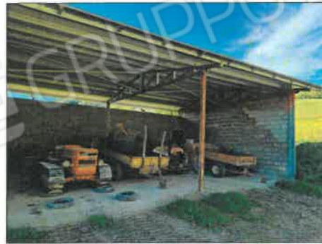
FOTO 33 - TETTOIA PER IL RICOVERO DI MEZZI AGRICOLI
