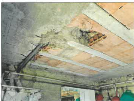
FOTO 47 - SOFFITTO GREZZO PIANO SEMINTERRATO
