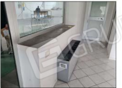
FOTO 48 - Ventilconvettori uffici
