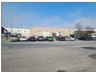
FOTO 04 - Vista del capannone
