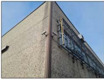
FOTO 35 - Impianto video sorv.
