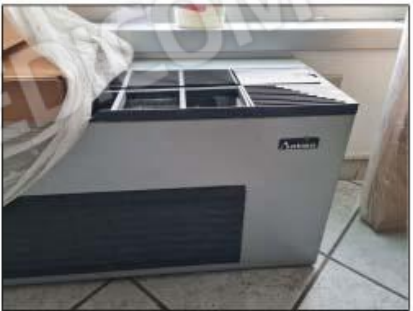
FOTO 46 - Ventilconvettori uffici
