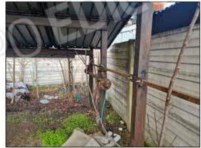
FOTO 15 - Tettoia in confine
