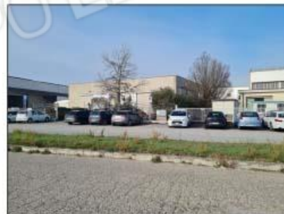
FOTO 03 - Vista del capannone
