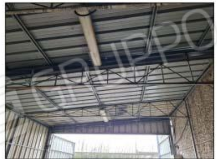
FOTO 33 - Copertura tettoia retro
