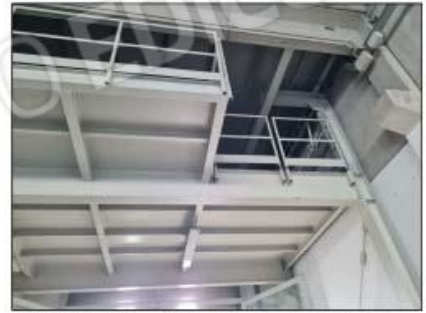
FOTO 27 - Struttura soppalco
