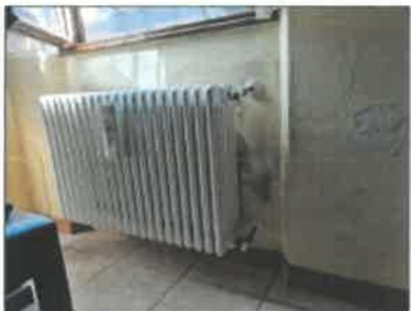
FOTO 52 - RADIATORE IN ACCIAIO
