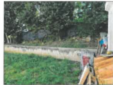
FOTO 18 - CONFINE SUL RETRO
