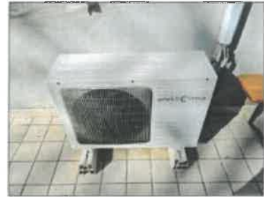
FOTO 51 - RAFFRESCAMENTO UNITA' ESTERNA
