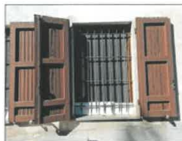
FOTO 27 - DETTAGLIO FINESTRA SUL FRONTE RETROSTANTE
