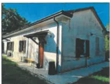
FOTO 07 - FRONTE RETROSTANTE E FRONTE LATERALE
