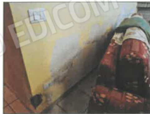
FOTO 63 - UMIDITA' DA RISALITA
