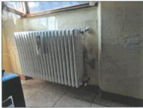
FOTO 52 - RADIATORE IN ACCIAIO
