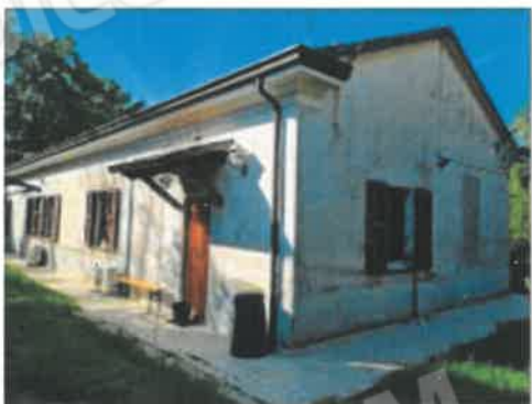
FOTO 07 - FRONTE RETROSTANTE E FRONTE LATERALE
