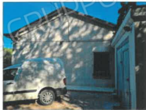
FOTO 09 - FRONTE LATERALE E VIST DELL'AUTORIMESSA
