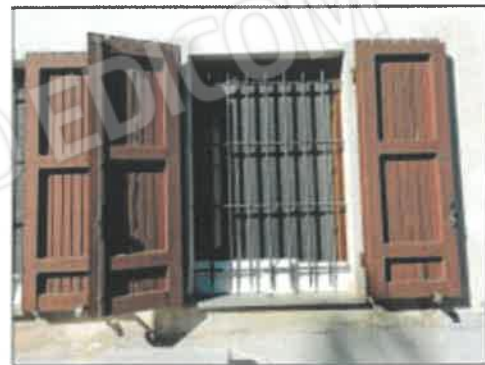
FOTO 27 - DETTAGLIO FINESTRA SUL FRONTE RETROSTANTE
