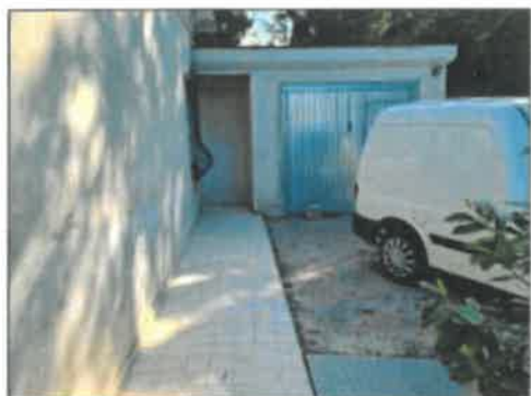
FOTO 13 - FRONTE LATERALE E VISTA DELL'AUTORIMESSA
