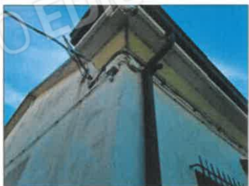
FOTO 22 - CORNICIONE E GRONDAIA
