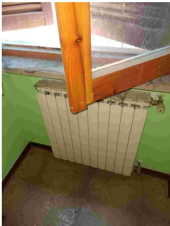
Particolare infissi e radiatori
