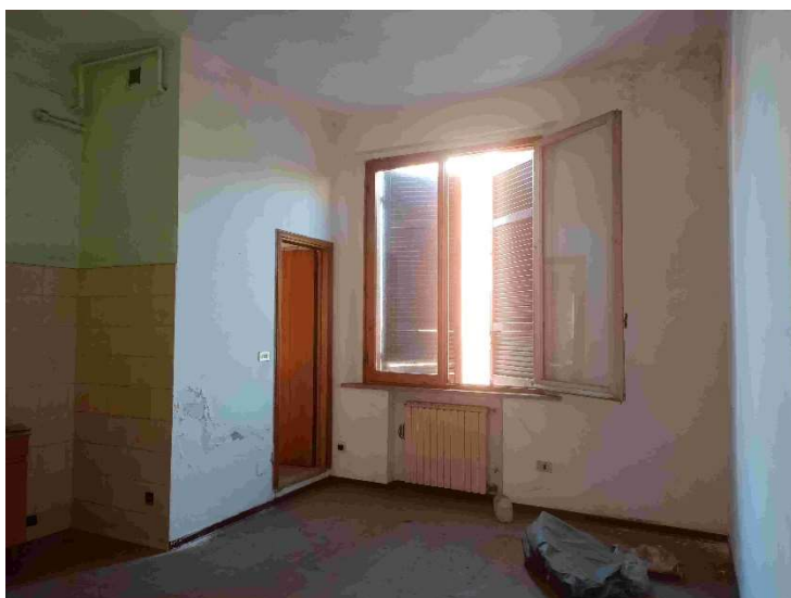
Vista soggiorno-cucina e porta dei servizi (anti e bagno)
