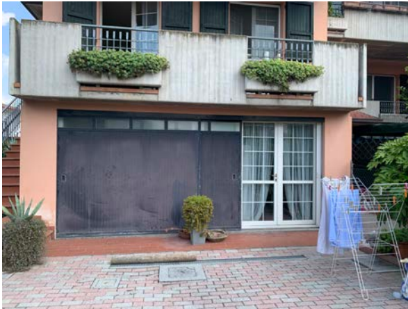
veduta della porta esterna di accesso all' autorimessa
