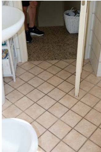
vedute del bagno posto al piano primo
