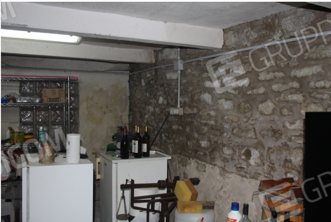
deposito piano seminterrato
