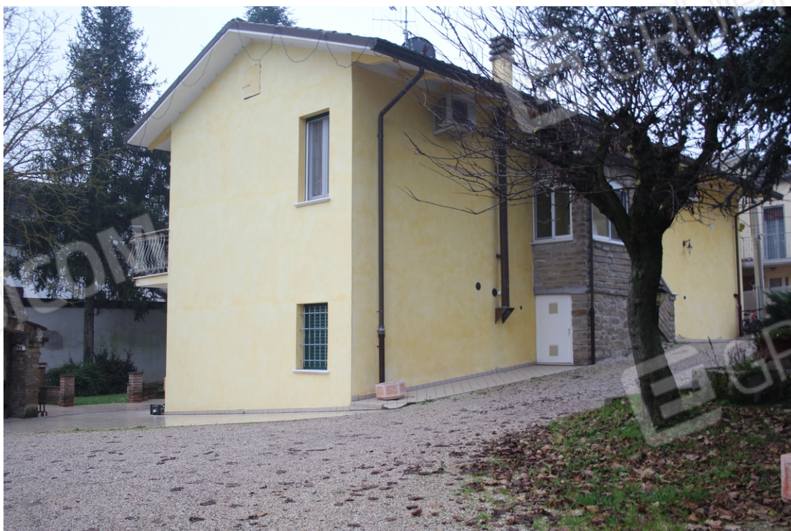
Vista edificio dalla corte
