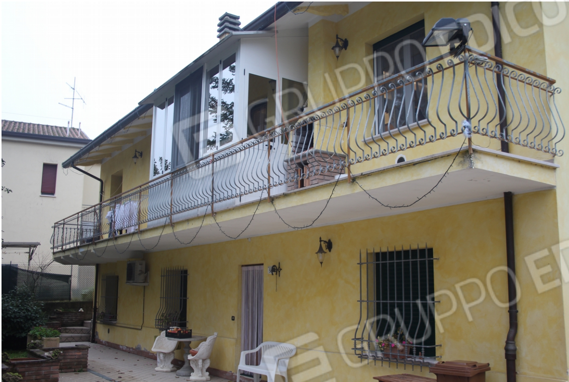
Vista edificio sul retro
