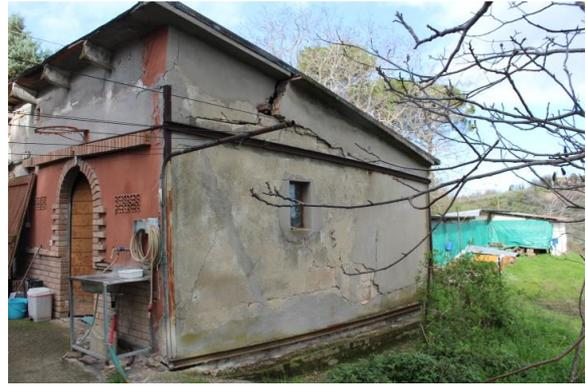
**PROSPETTO EST – PARTICOLARE DELLA GRAVE LESIONE STRUTTURALE**
