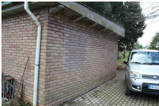
**PROSPETTO A OVEST; PARTICOLARE DELLE DUE FINESTRE TAMPONATE CON *CHIAVI* DELLA MURATURA PER RIPRISTINO STATO LEGITTIMO**
