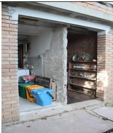
**TAMPONATURA DEMOLITA SUL LATO EST PER RIPRISTINO STATO LEGITTIMO**
