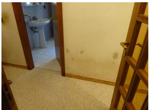
Al piano terra lungo le pareti principali e perimetrali vi è una forte presenza di umidità di risalita con distacco ed esfoliazione della tinteggiatura.
