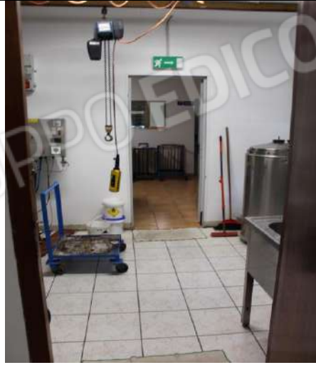
LOCALI AL PIANO TERRA
