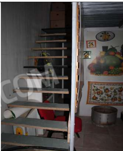
SCALA DI ACCESSO A LOCALI POSTI AL SECONDO PIANO
