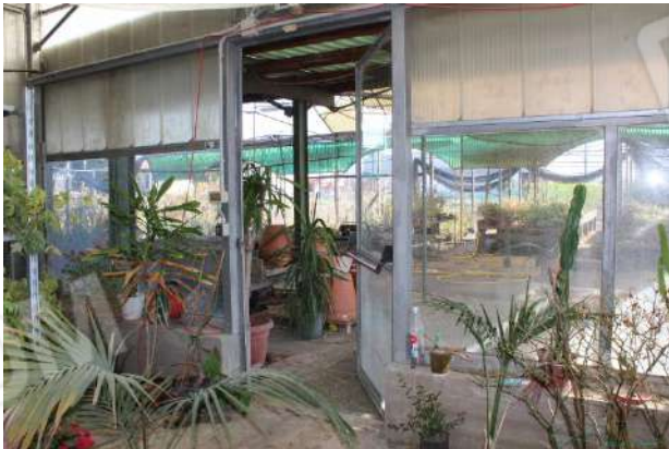
TETTOIA E INGRESSO AL DEPOSITO
