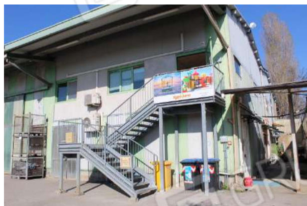
CORPO SUL RETRO, CON SCALA ESTERNA DI ACCESSO AI LOCALI PIANO PRIMO
