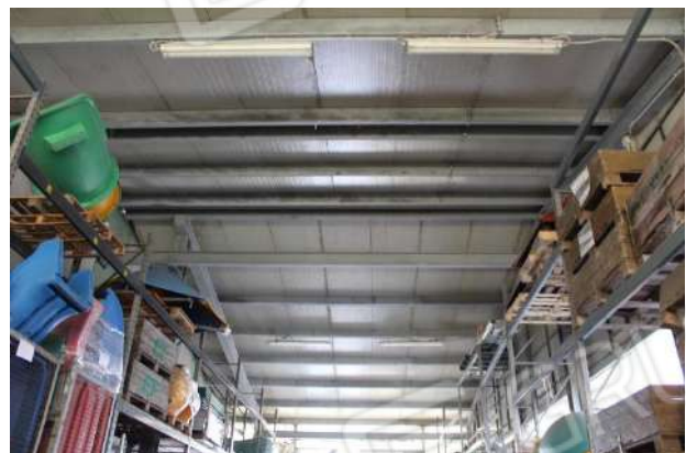
DEPOSITO, PARTICOLARE COPERTURA
