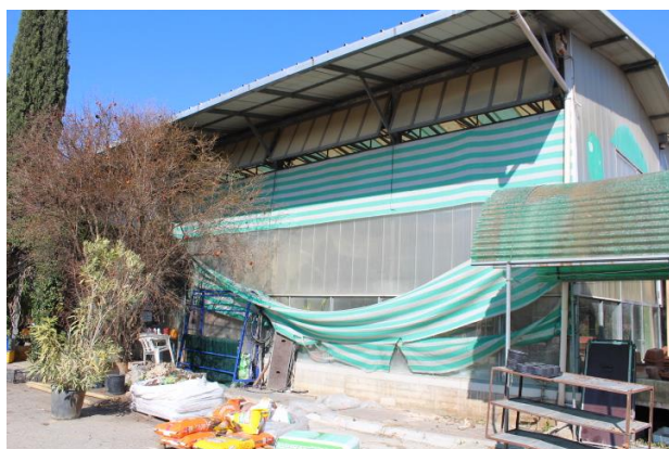
CORPO DI FABBRICA LATO STRADA
