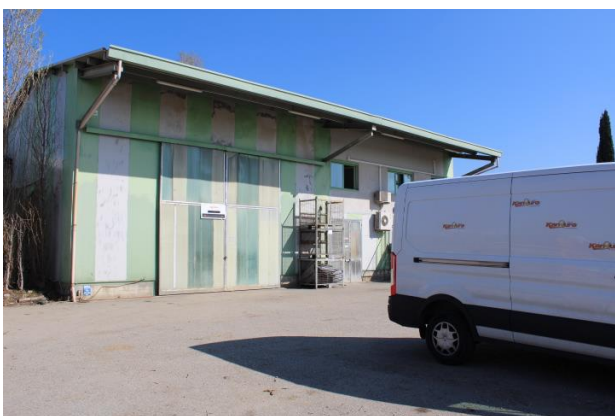
CORPO DI FABBRICA SUL RETRO
