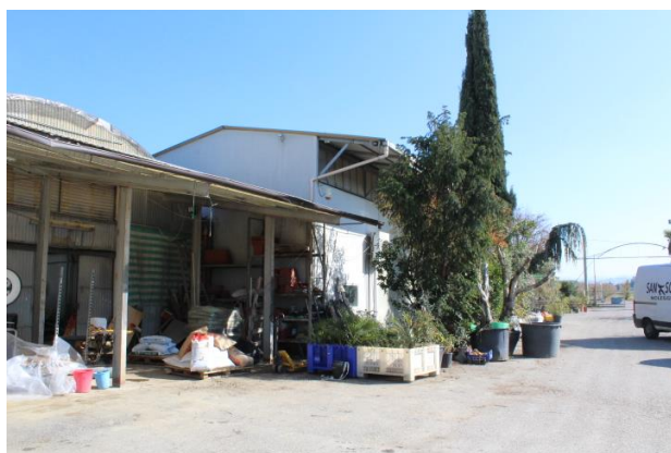
CORPO DI FABBRICA LATO STRADA
