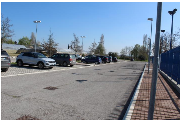
TERRENO CON SOVRASTANTI OPERE DI URBANIZZAZIONE, ABUSIVE MA SANABILI
