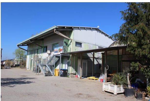
CORPO DI FABBRICA SUL RETRO
