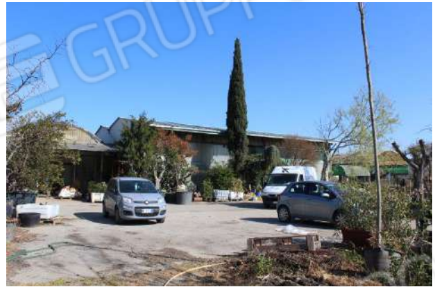
TERRENO A OVEST, ANTISTANTE I CORPI DI FABBRICA
