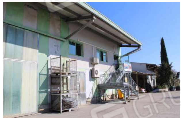
PARTICOLARE CORPO DI FABBRICA SUL RETRO
