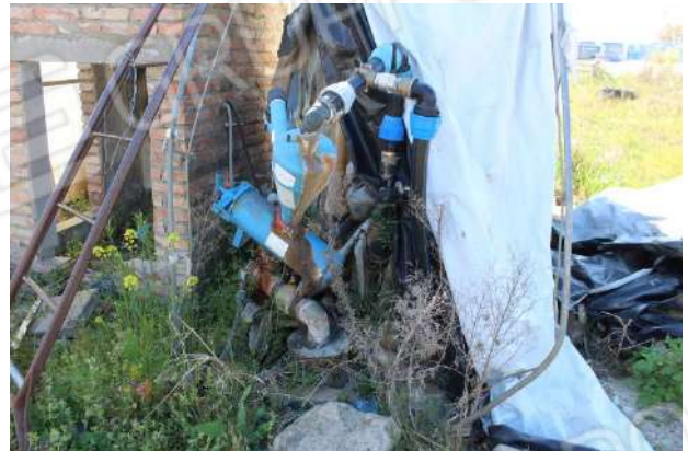
PARTICOLARE DEL POZZO
