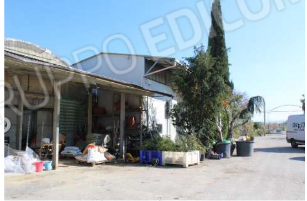
CORPO LATO STRADA CON SERRE
