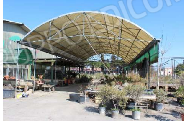
SERRE COPERTURA PIANTE
