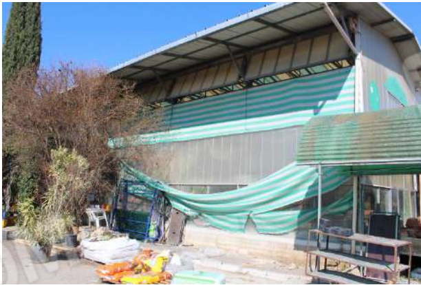
CORPO DI FABBRICA VICINO ALLA STRADA
