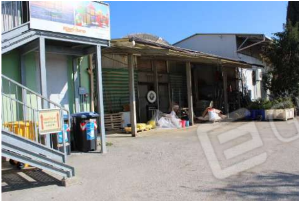
TETTOIA A COLLEGAMENTO CORPO LATO STRADA CON QUELLO SUL RETRO
