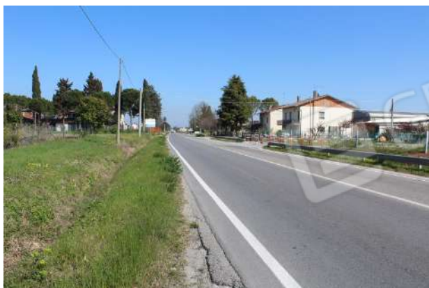
VIA CALCINARO DIREZIONE EST, CASELLO AUTOSTRADA
