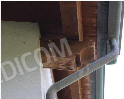
**PARTICOLARE GRONDAIA CON GRIGLIA PER LA VENTILAZIONE DELLA COPERTURA**
