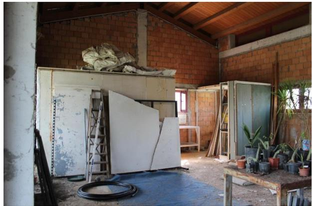
**INTERNO, PARTICOLARE MURATURE NON INTONACATE E SOLETTA IN CLS PRIVA DI PAVIMENTAZIONE**
