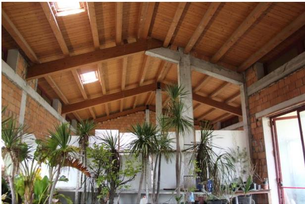
**INTERNO, PARTICOLARE DELLA COPERTURA IN LEGNO E DEI DUE LUCERNAI IN COPERTURA (non regolari)**
