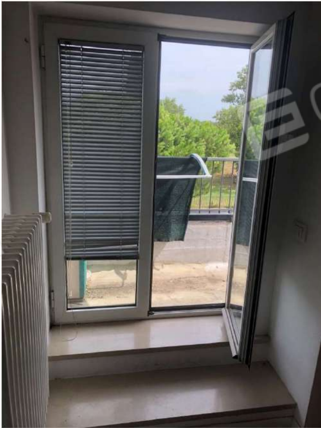
Foto 17 – accesso al terrazzo
