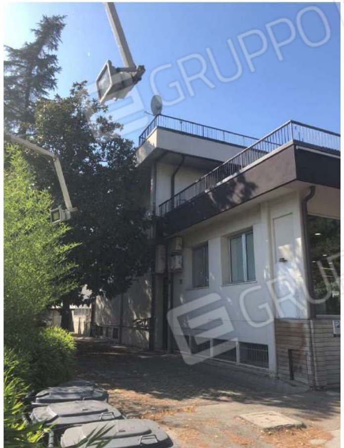
Foto 4 - Prospetto Sud-Ovest – Viale Roma
