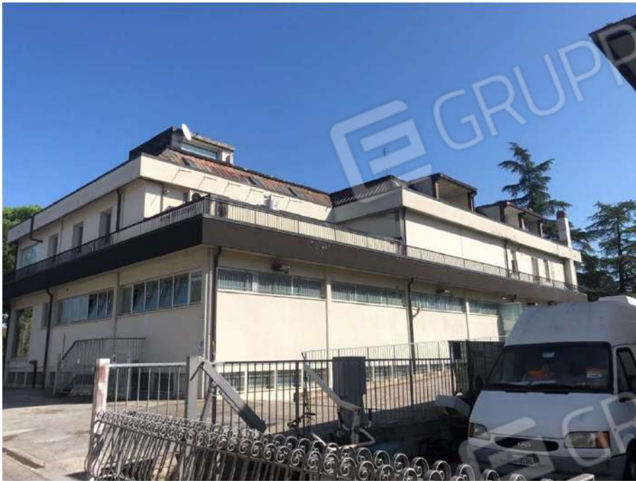
Foto 3 - Prospetto Sud-Ovest – Viale Roma
