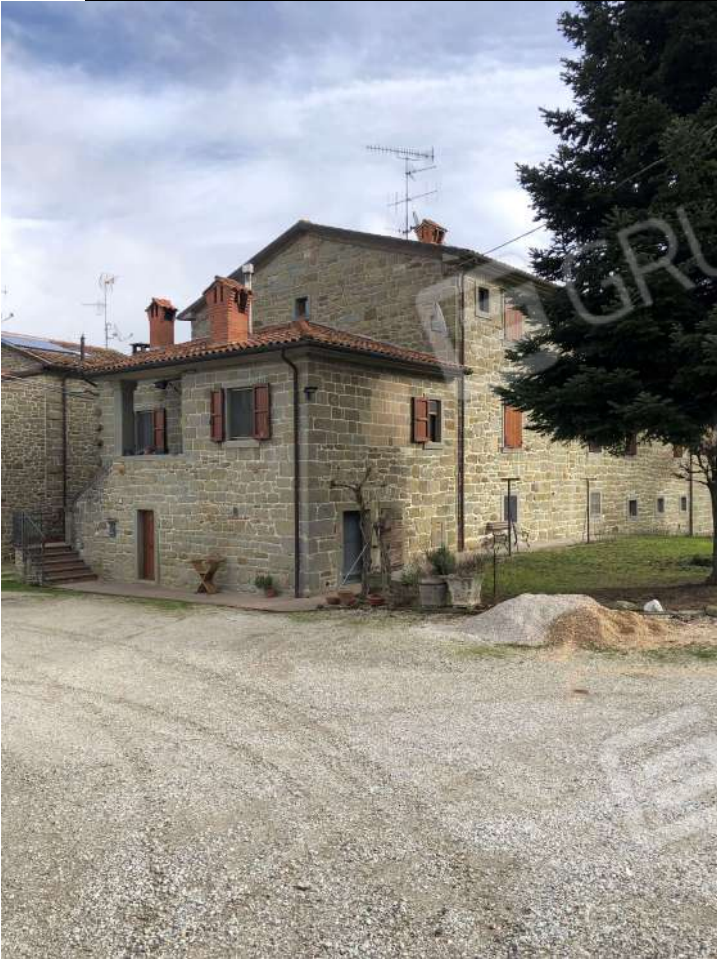
Foto 3- P.Ila 256 – Prospetto Ovest
