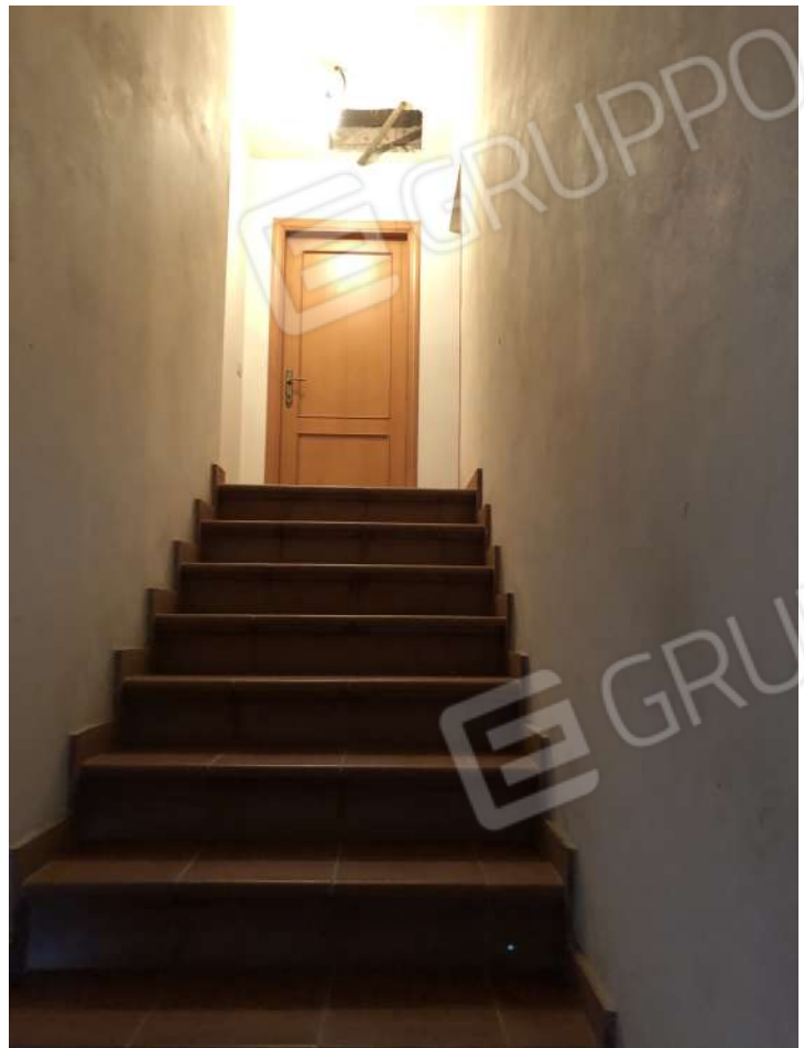
Foto 20- Piano 1 – scala al secondo piano
