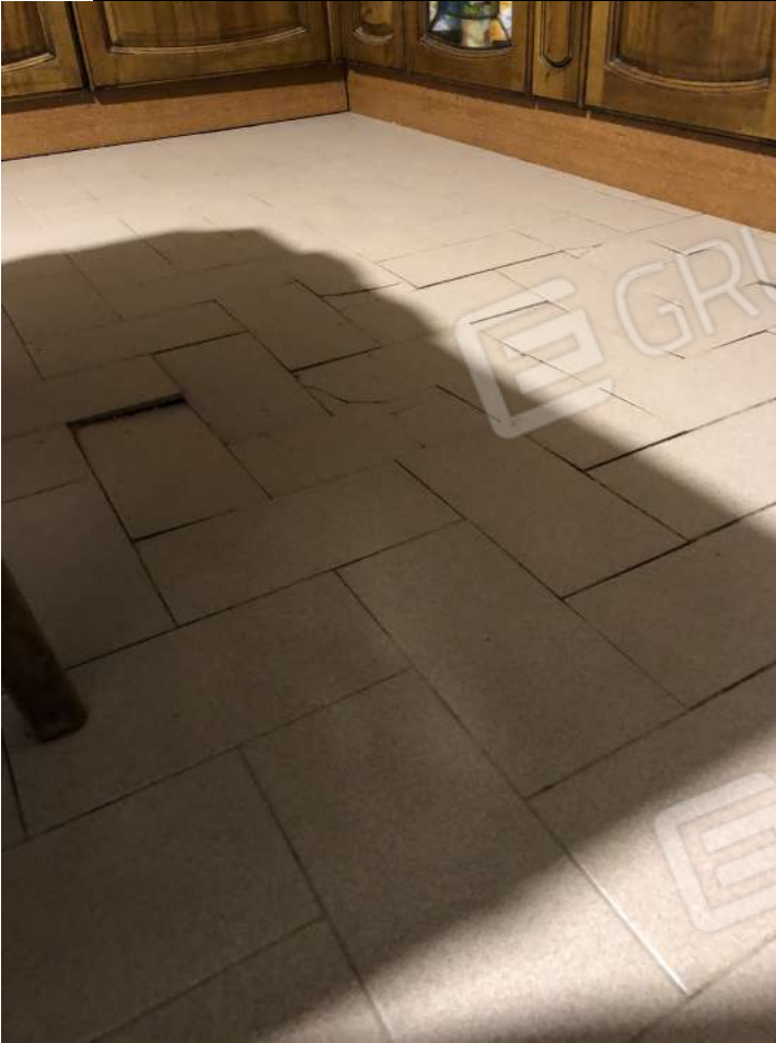
Foto 17- Piano 1 – cucina (dettaglio solaio e pavimento)
