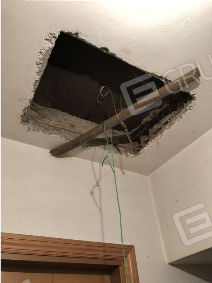
Foto 21- Piano 2 – pianerottolo di sbarco (dettaglio botola al sottotetto)
