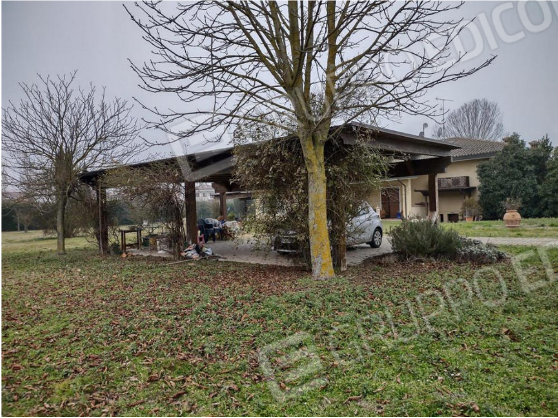
FOTO 5. La tettoia (non autorizzata) sull'area parcheggio
