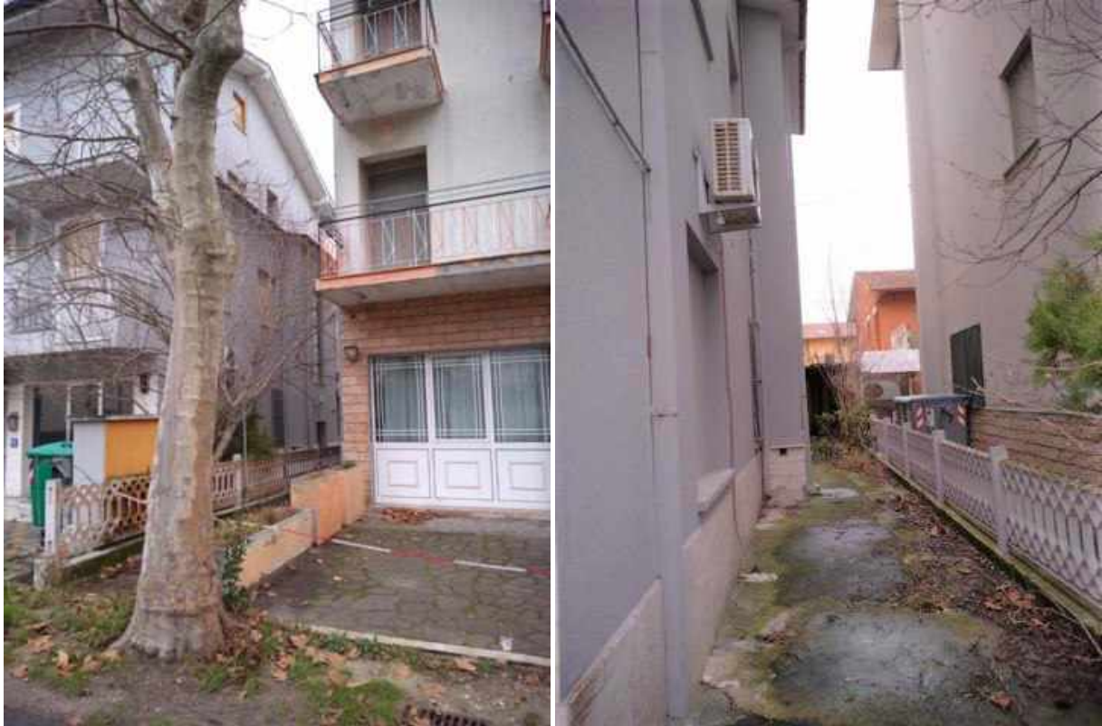
FOTO 4 e 5. Prospetto laterale nord e porzione di corte sullo stesso lato
