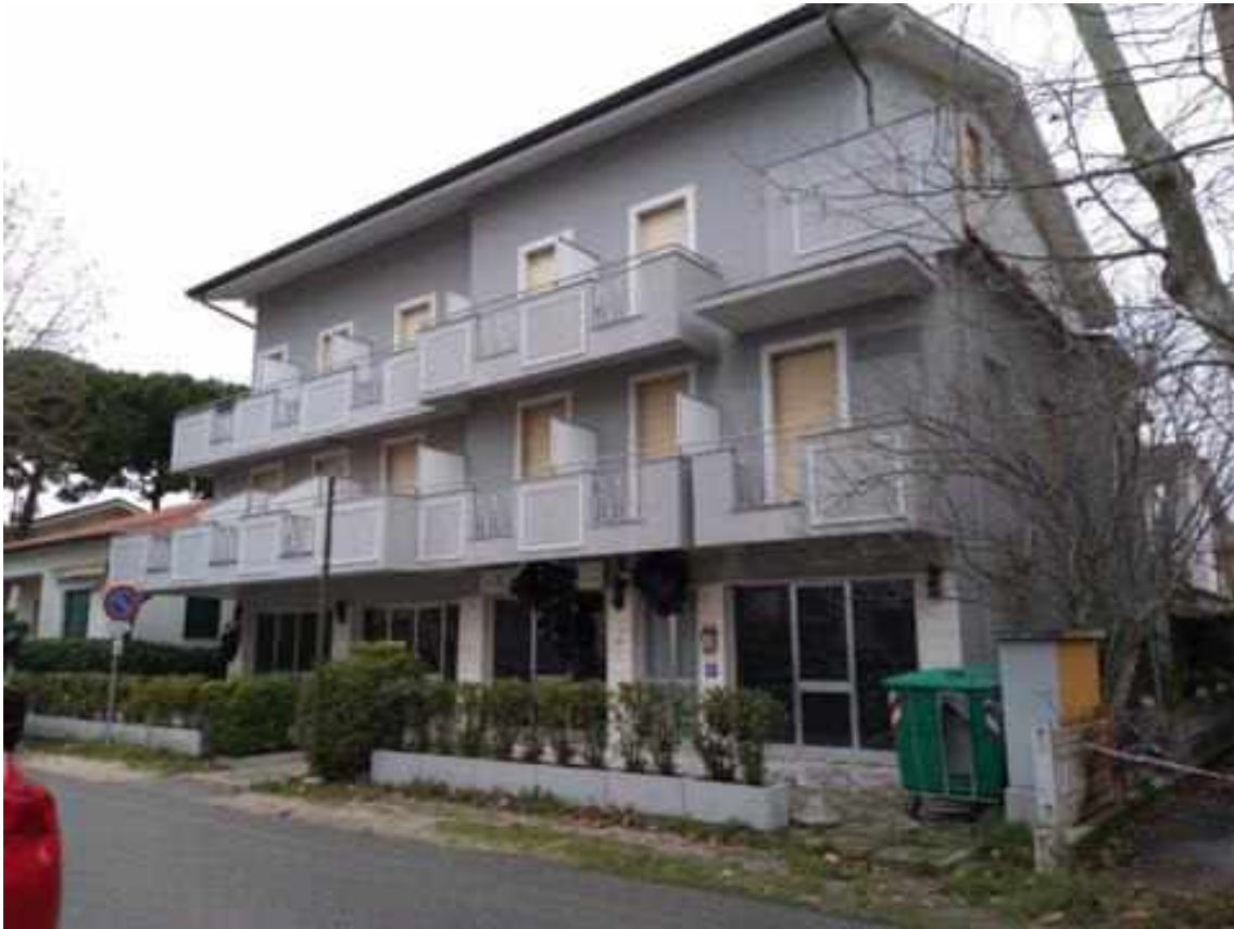
FOTO 1. Fronte su via Talete da Mileto
