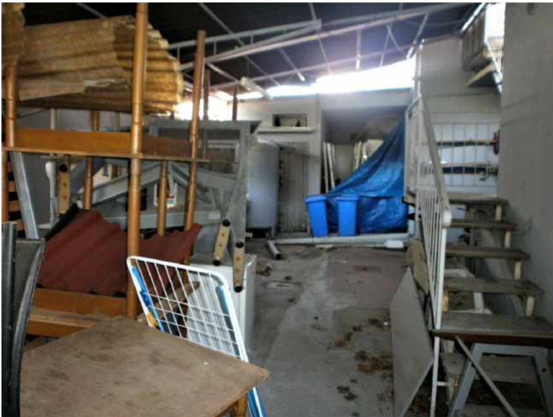
FOTO 45. Piano Terra: tettoia e servizi sul retro ( fabbricato secondario)
