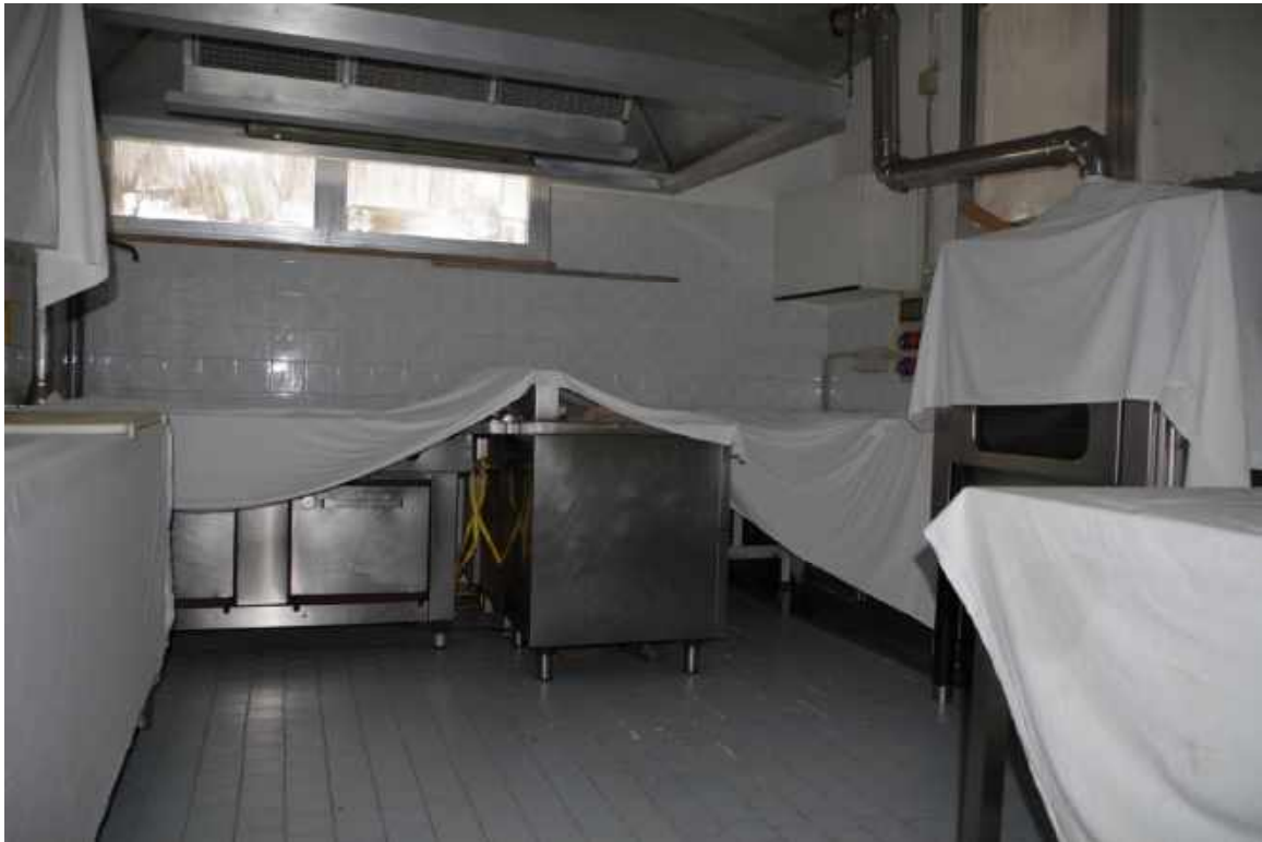
FOTO 12. Piano Terra: cucina
