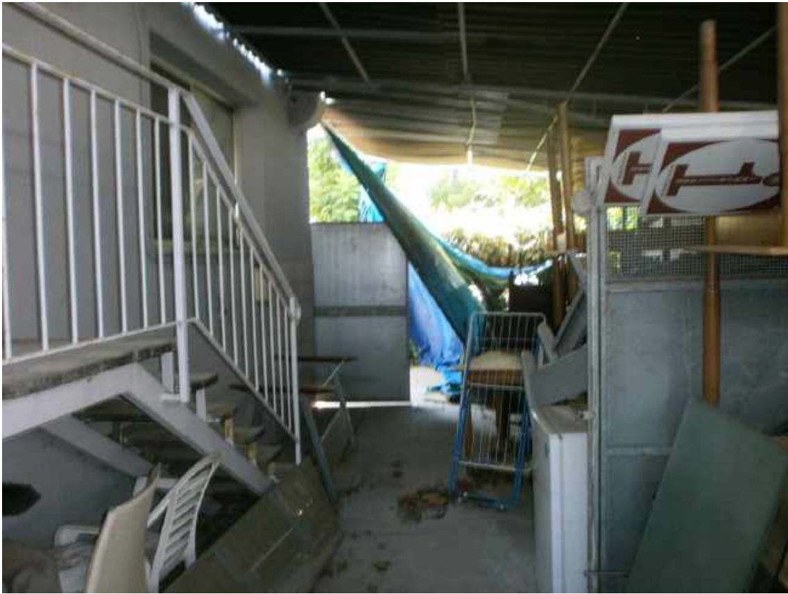
FOTO 46. Piano Terra: tettoia sul retro
