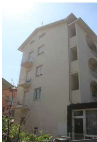
Foto 2: vista lato est
