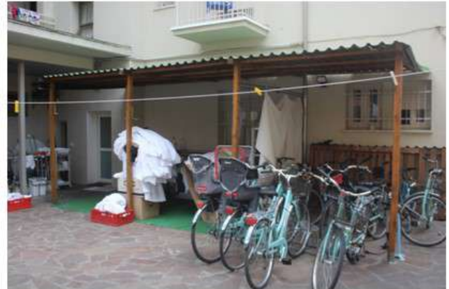
Foto 7: corte retro con tettoia non annotata
