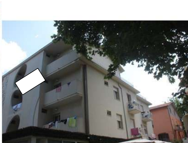
Foto 4: vista lato ovest
