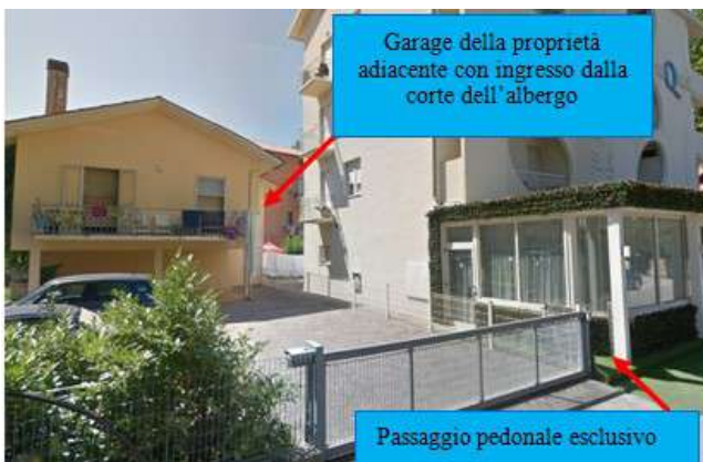
Foto 10: organizzazione degli spazi di corte lato est
