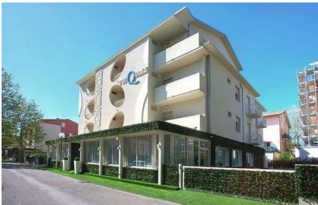
Foto 1: vista generale sull'edificio da viale Aristotele
