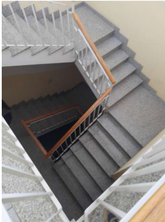
8 – VANO SCALA CONDOMINIALE
