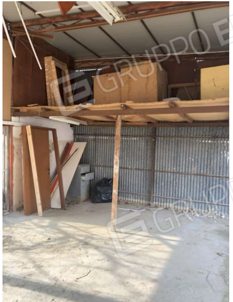
Foto 28- Piano S1/ TERRA -Sub.17 Deposito
