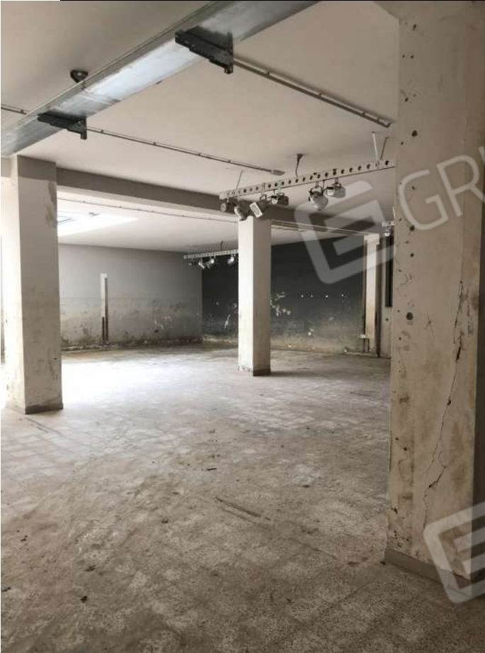
Foto 13- Piano 1° seminterrato – mostra
