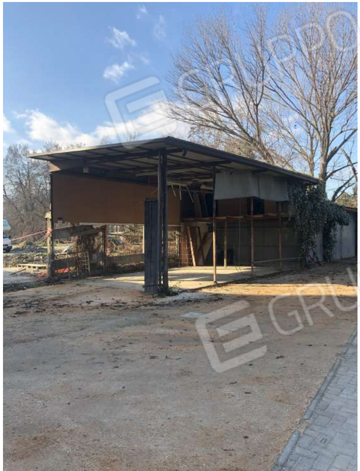
Foto 26- Piano S1/ TERRA -Sub.17 Deposito
