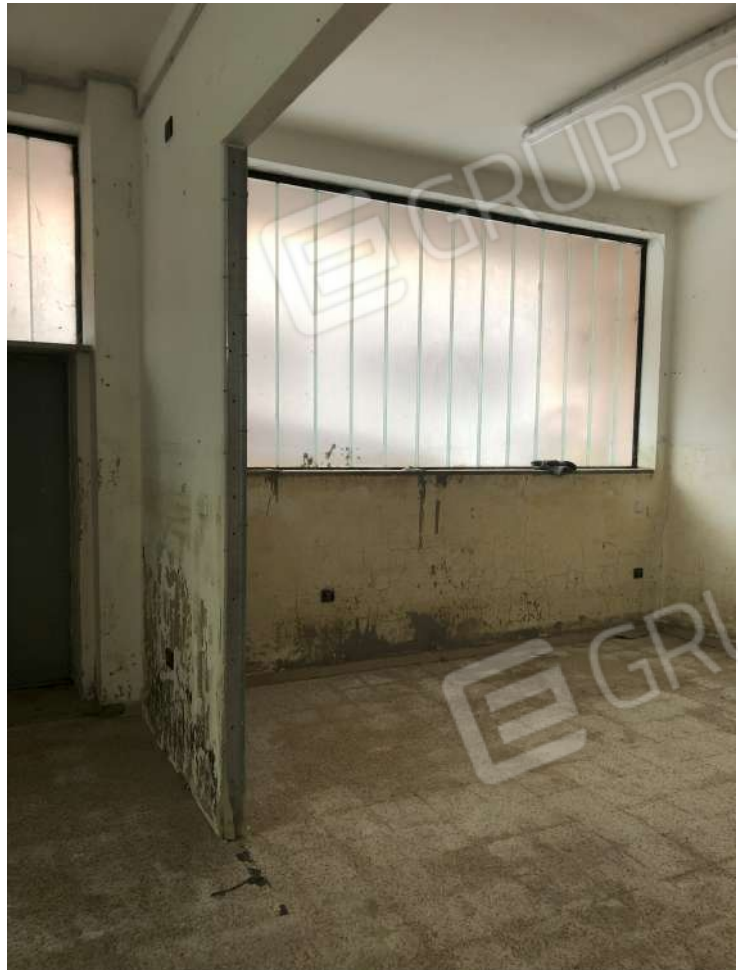
Foto 21- Piano 1° seminterrato – WC
