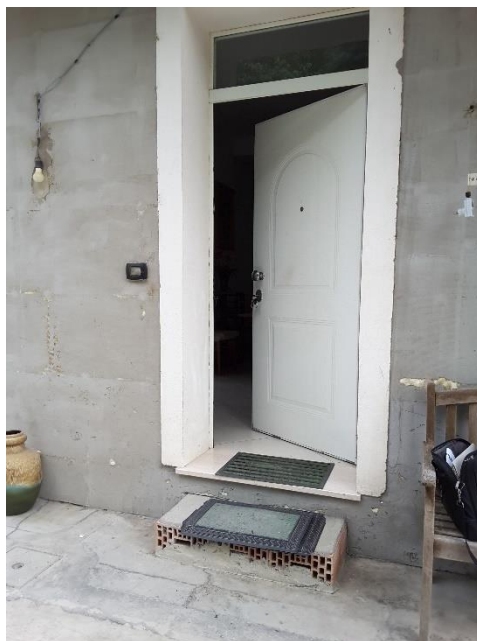
Vista portoncino d'ingresso
