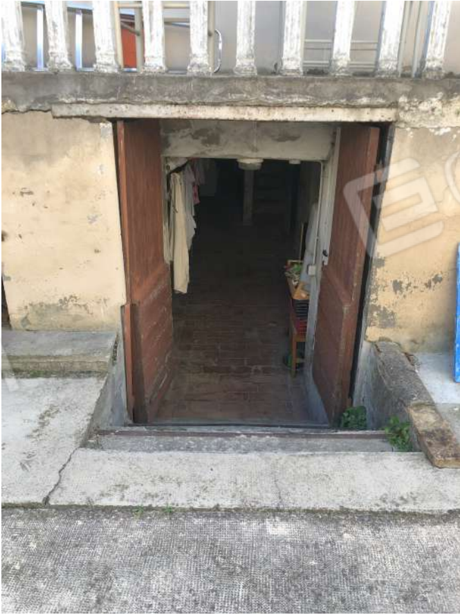
Foto 5- Accesso esterno al piano seminterrato
