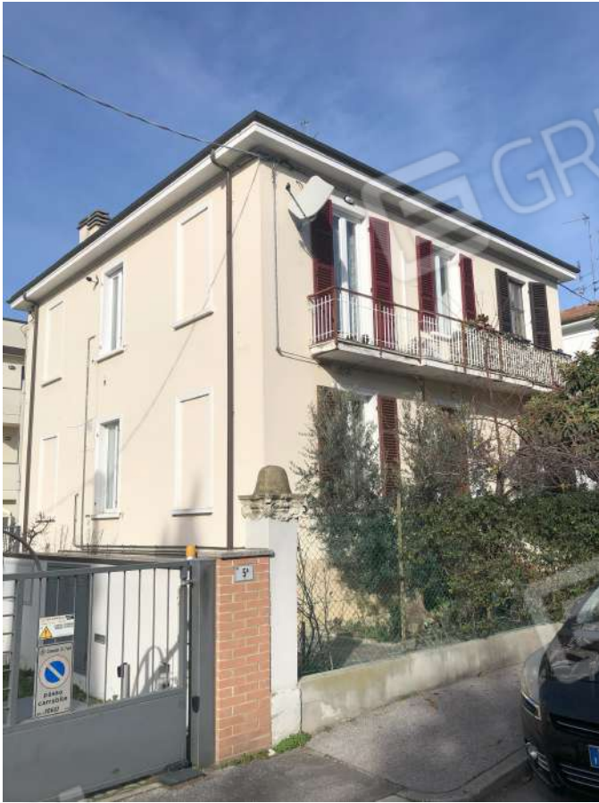
Foto 1- Prospetto frontale e laterale da Ugolino da Forlì
