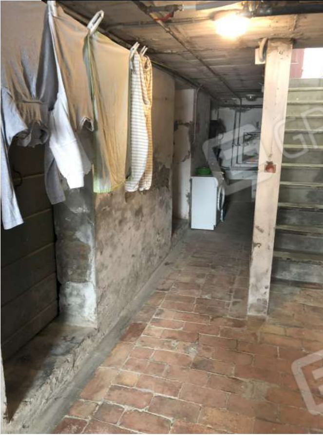
Foto 13- Piano seminterrato – area comune
