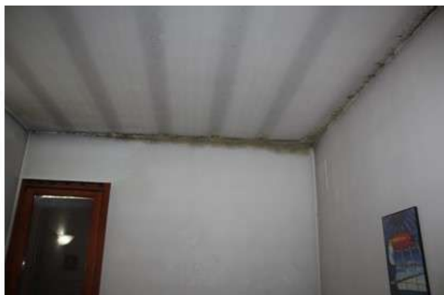
Foto 23-24: evidenti tracce di umidità in cucina ed in camera da letto
