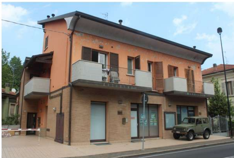
Foto 1: edificio cui appartengono le unità pignorate – prospetto principale sud su via Fiorenzuola
