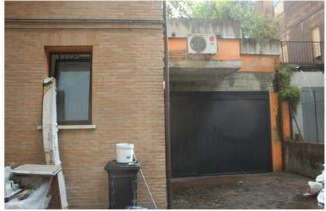
Foto 7: parte terminale est della corte sul retro
