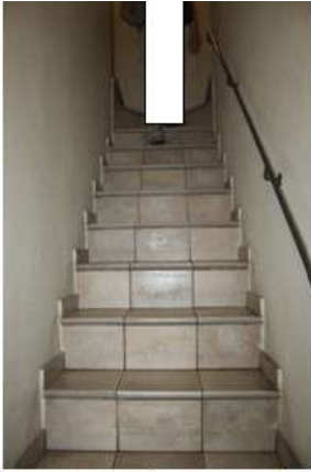
Foto 26: scala esterna di accesso
