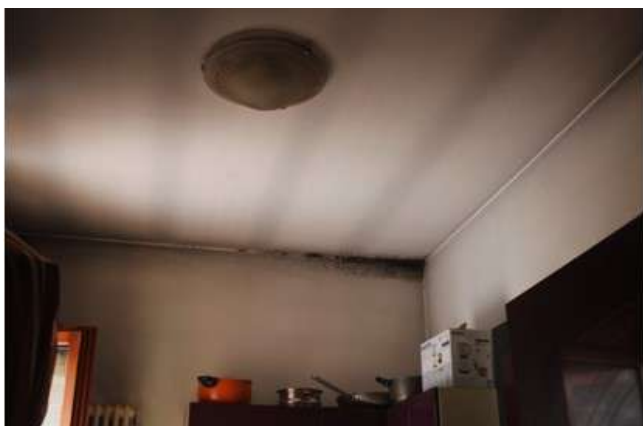
Foto 23-24: evidenti tracce di umidità in cucina ed in camera da letto
