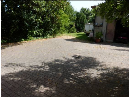
Foto 11, area pavimentata situata tra edificio principale e corpo garage
