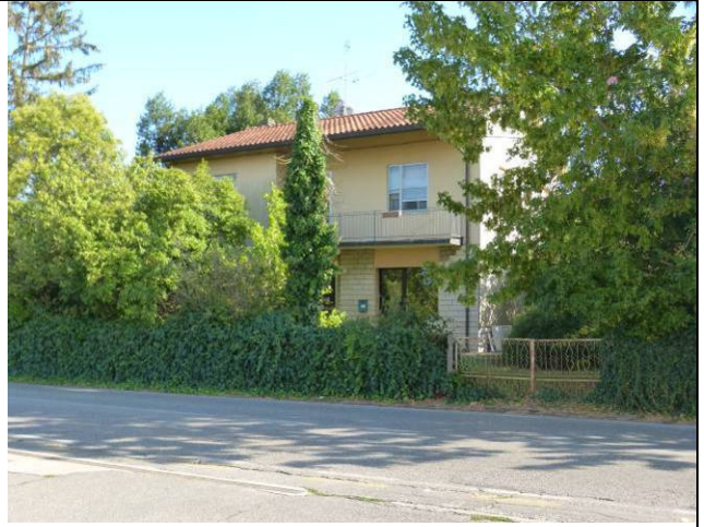
Foto 2, prospetto Nord, fronte strada
