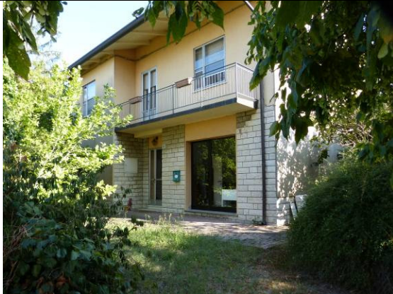
Foto 3, particolare del prospetto Nord con vetrina e accesso principale all'abitazione
